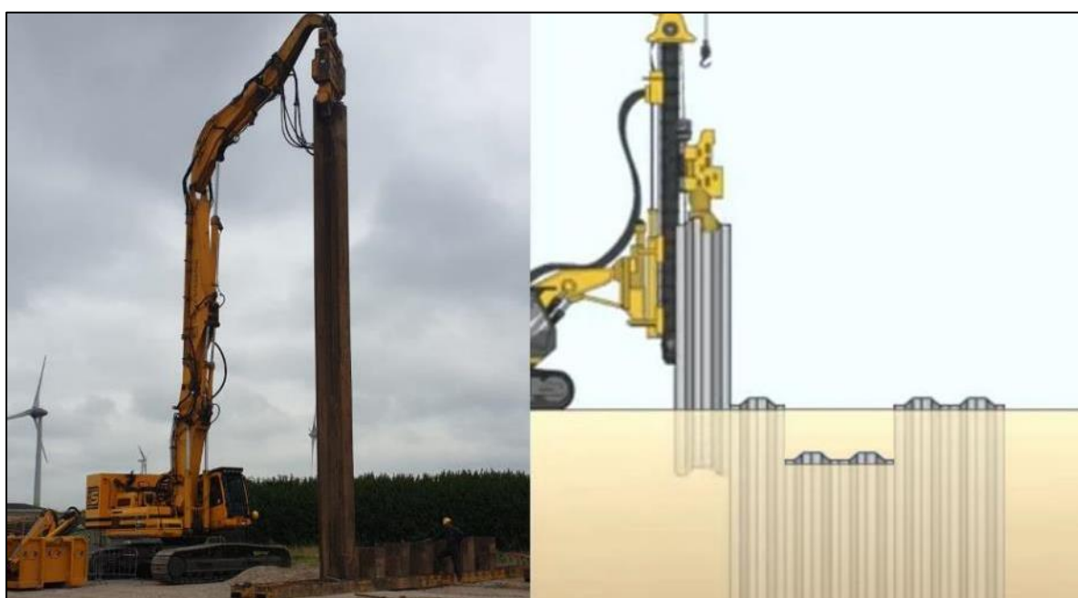
Figuur 4-3: Voorbeeld installatie dodebed
