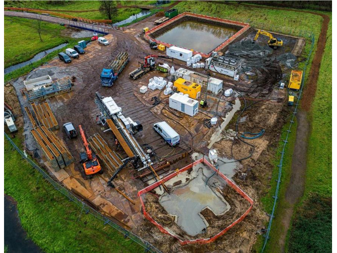
HDD – Horizontaal gestuurde boring
