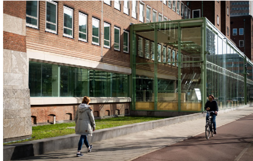
De glazen traverse langs het hoofdgebouw van de ministeries verbindt de verticale knooppunten van het gebouw en zorgt voor isolatie.
