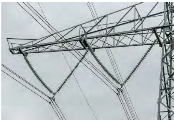
Figuur 6 Principe ophanging isolator kettingen met HE-balken
