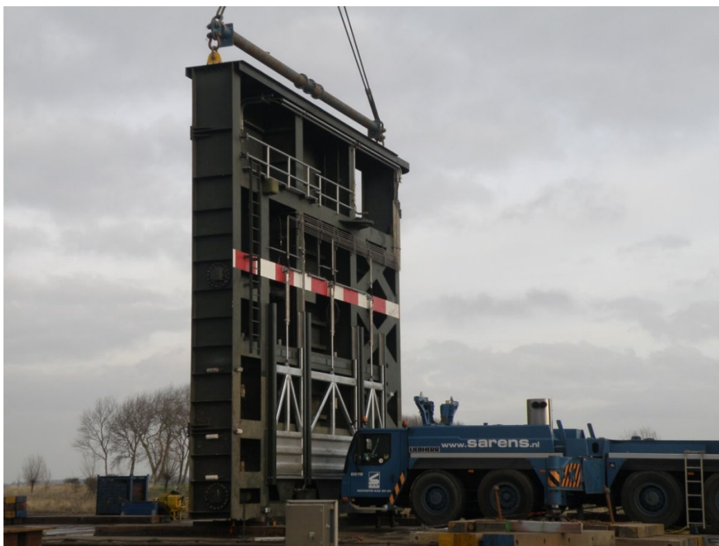
Figuur 2-3 Jachtensluisdeur met rinketschuiven (Bron: https://beeldbank.rws.nl , Rijkswaterstaat / Kees-Jan Meeuse)
