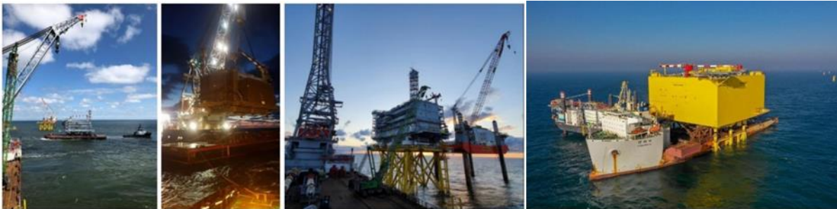
Figuur 3-9 Plaatsen van de topside door middel van een kraan (drie afbeeldingen links) of door deze over de jacket te varen (foto rechts)
