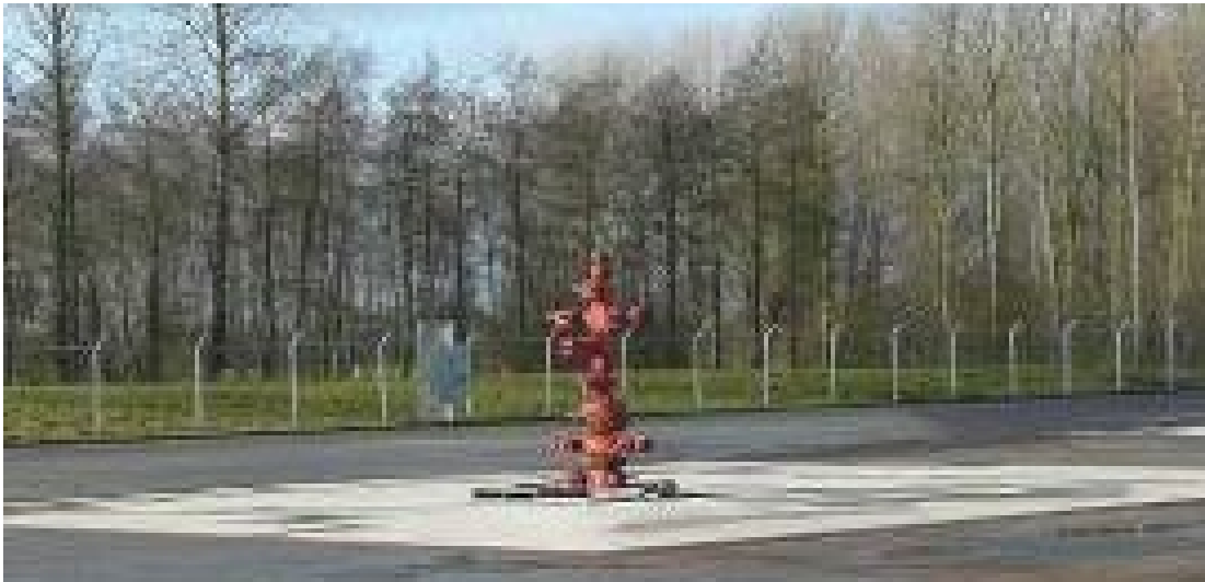
Figuur 5 voorbeeld van een spuitkruis (mijnbouwlocatie De Hoeve).
