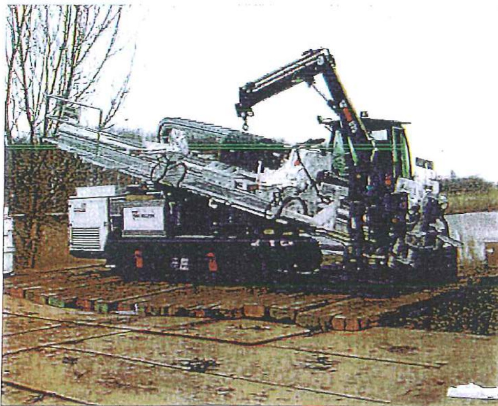
Afbeelding: 100 tons boor-rig Van Vulpen
