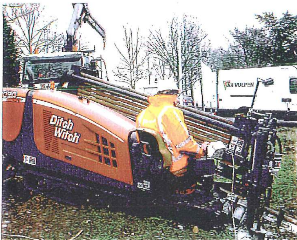
Afbeelding: 16 tons boor-rig Van Vulpen
