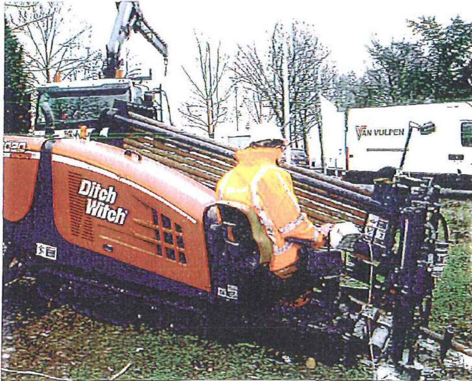
Afbeelding: 10 tons boor-rig Van Vulpen
