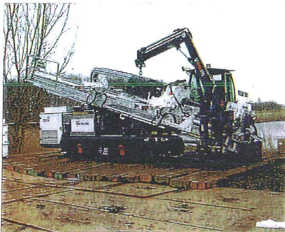
Afbeelding: 100 tons boor-rig Van Vulpen
