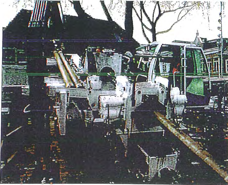
Afbeelding: 80 tons boor-rig Van Vulpen
