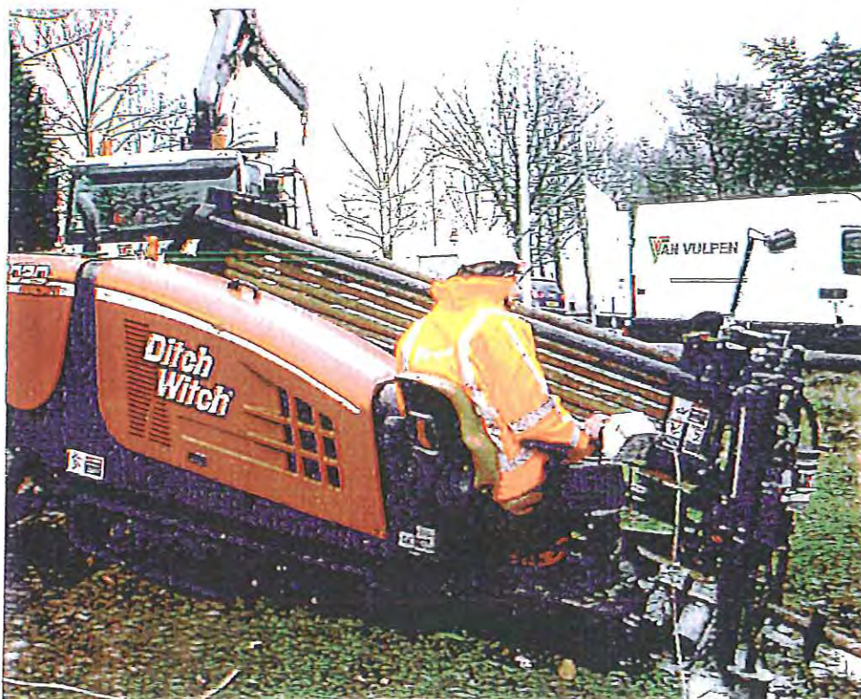
Afbeelding: 16 tons boor-rig Van Vulpen
