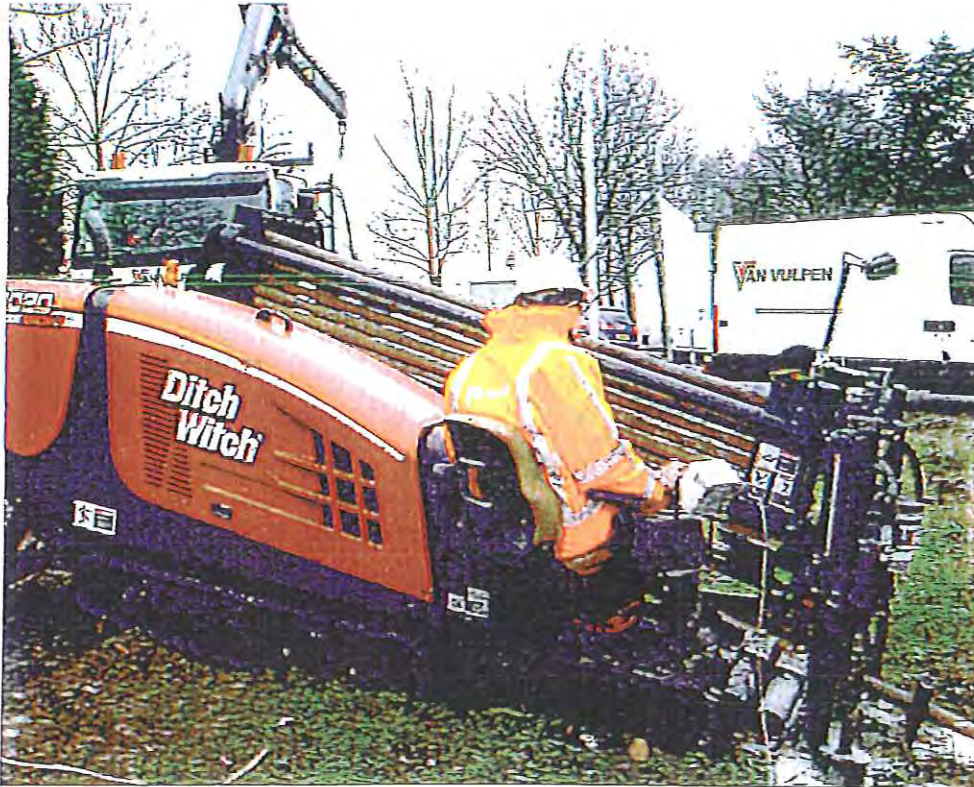
Afbeelding: 10 tons boor-rig Van Vulpen
