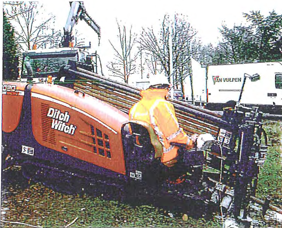
Afbeelding: 10 tons boor-rig Van Vulpen
