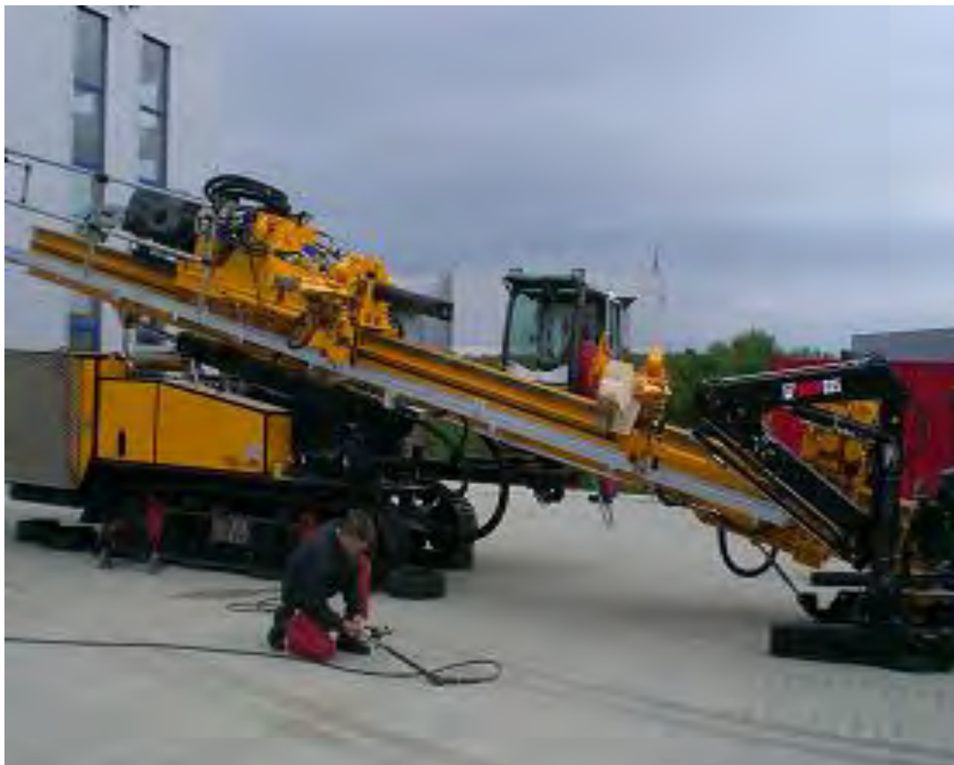
Figuur 2: 100 tons boorinstallatie
