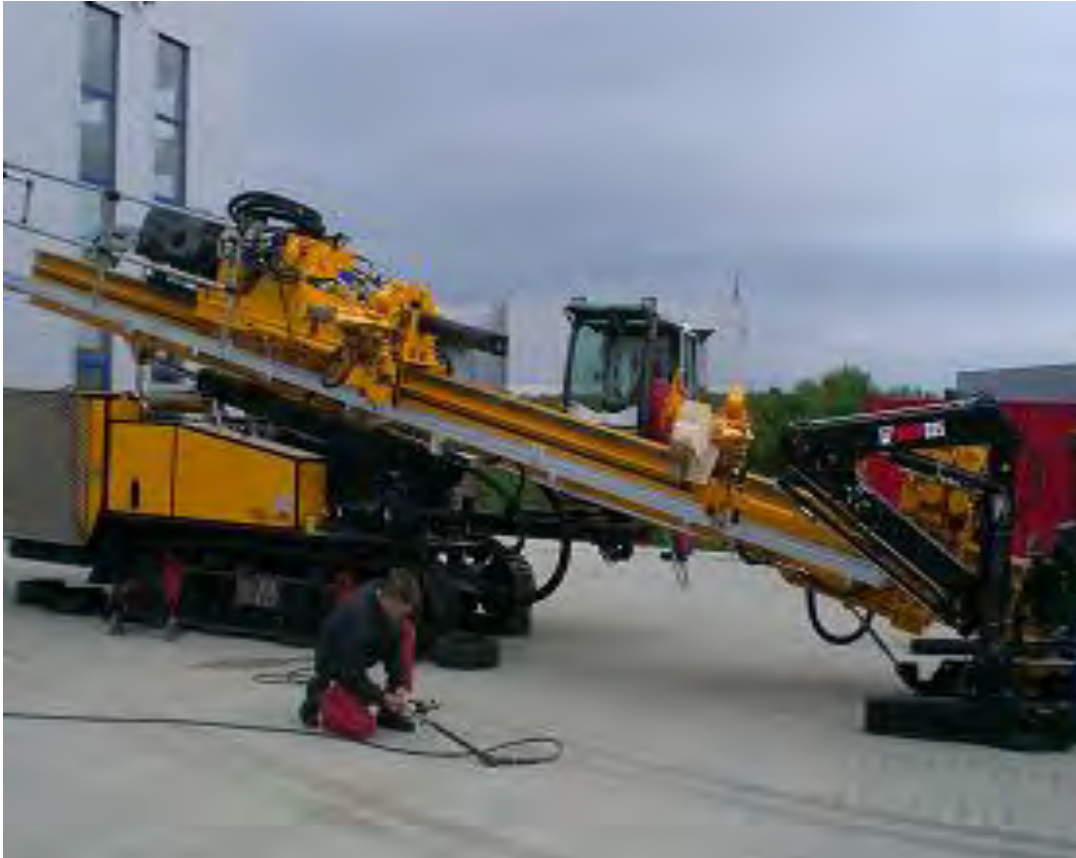
Figuur 1: 100 tons boorinstallatie
