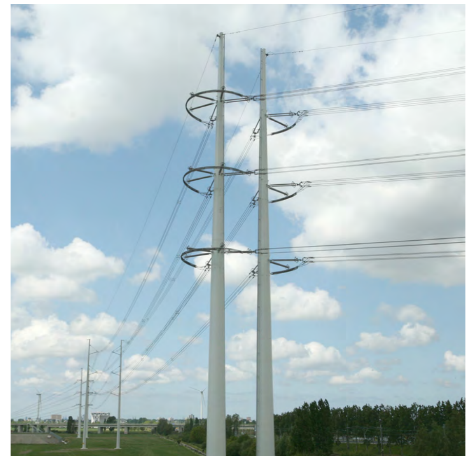
Highstep klimrail (t.b.v. onderhoud) in lijn met de verticaliteit van de masten
