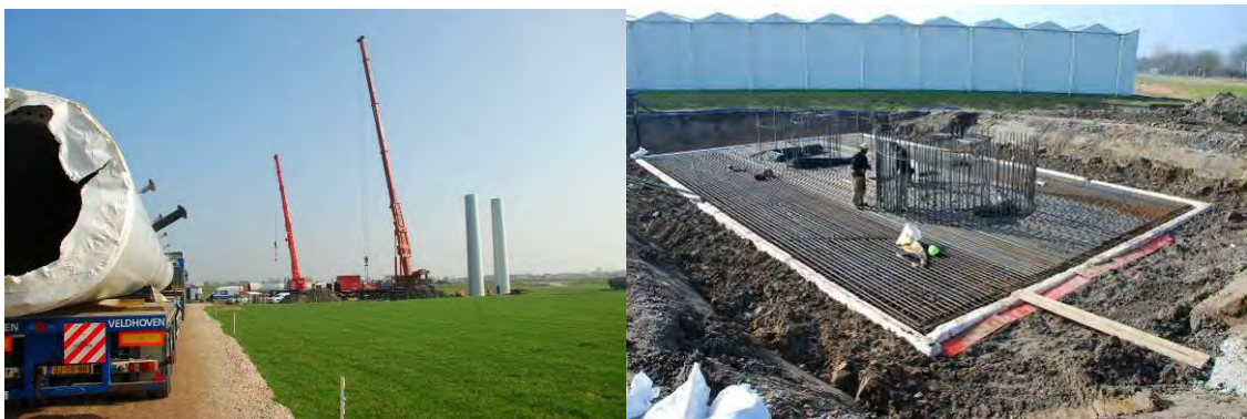
Figuur 2.5 Een tijdelijke bouwweg door een weiland en het bouwterrein rondom de mastvoet.
