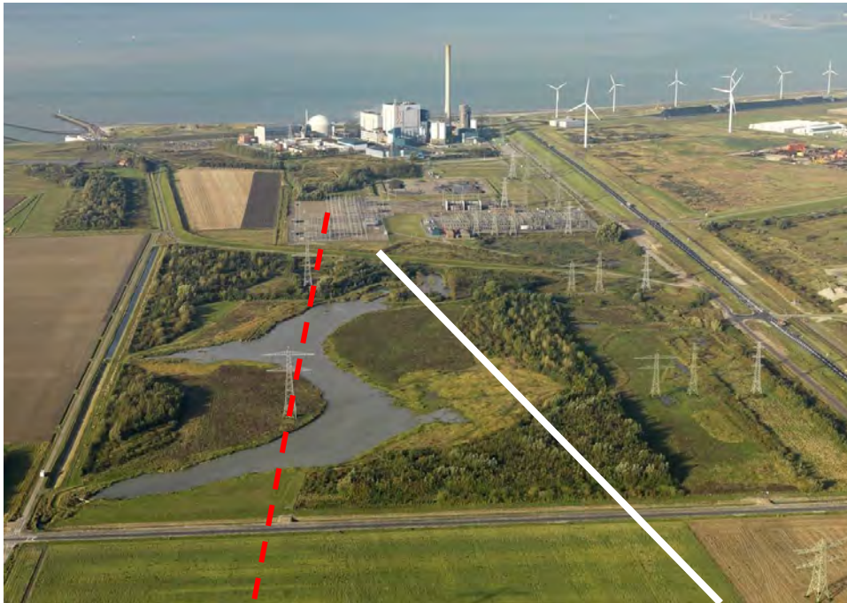
Sloebos. De bestaande 380 kV verbinding (rood) wordt gesloopt na ingebruikname van de nieuwe verbinding (witte lijn is indicatie van tracé)
