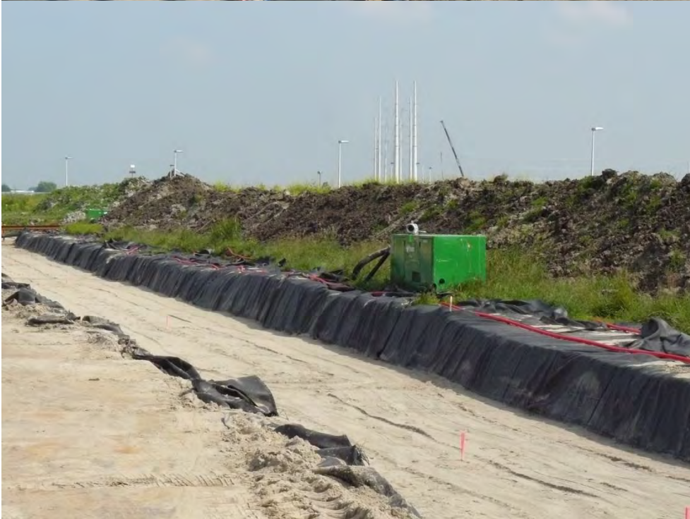
380kV kabel Randstad
