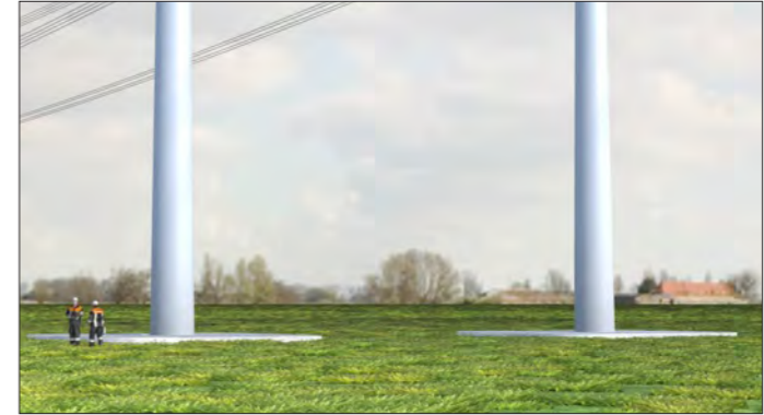
Fundatie over geheel 0,3m boven maaiveld.
