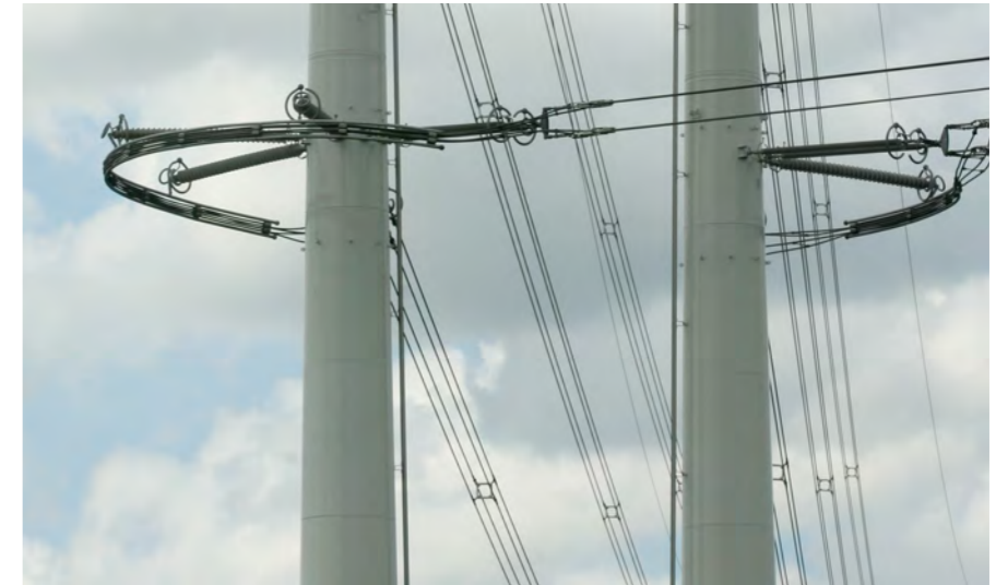
De Highstep en de subtiele aanhechtingen (clips) voor onderhoud
