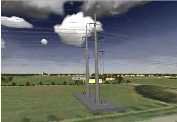
Afbeelding 4 – Impressie opstijgpunt 150 kV
