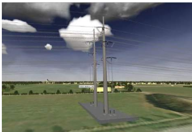
Afbeelding 4 Impressie opstijgpunt 150 kV
