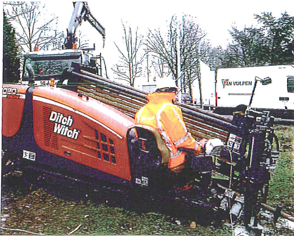
Afbeelding: 10 tons boor-rig Van Vulpen
