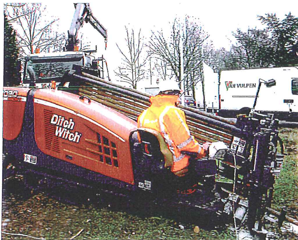
Afbeelding: 16 tons boor-rig Van Vulpen
