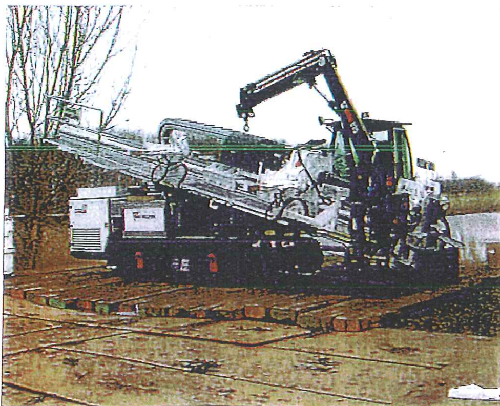
Afbeelding: 100 tons boor-rig Van Vulpen
