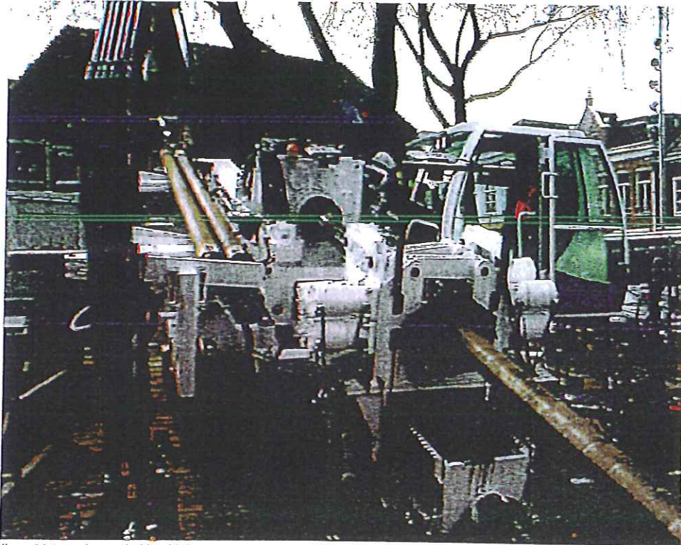
Afbeelding: 80 tons boor-rig Van Vulpen
