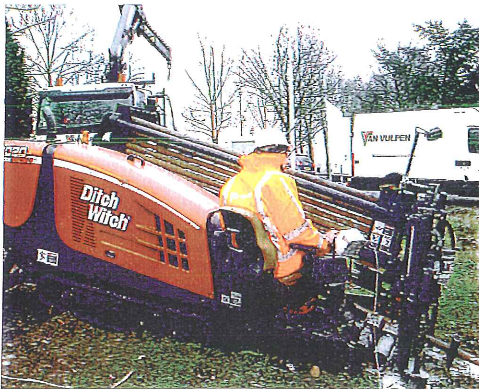
Afbeelding: 10 tons boor-rig Van Vulpen
