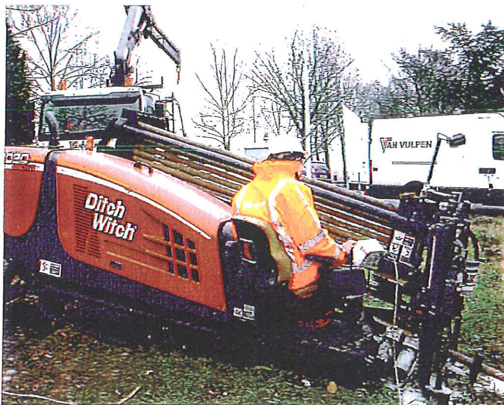
Afbeelding: 16 tons boor-rig Van Vulpen
