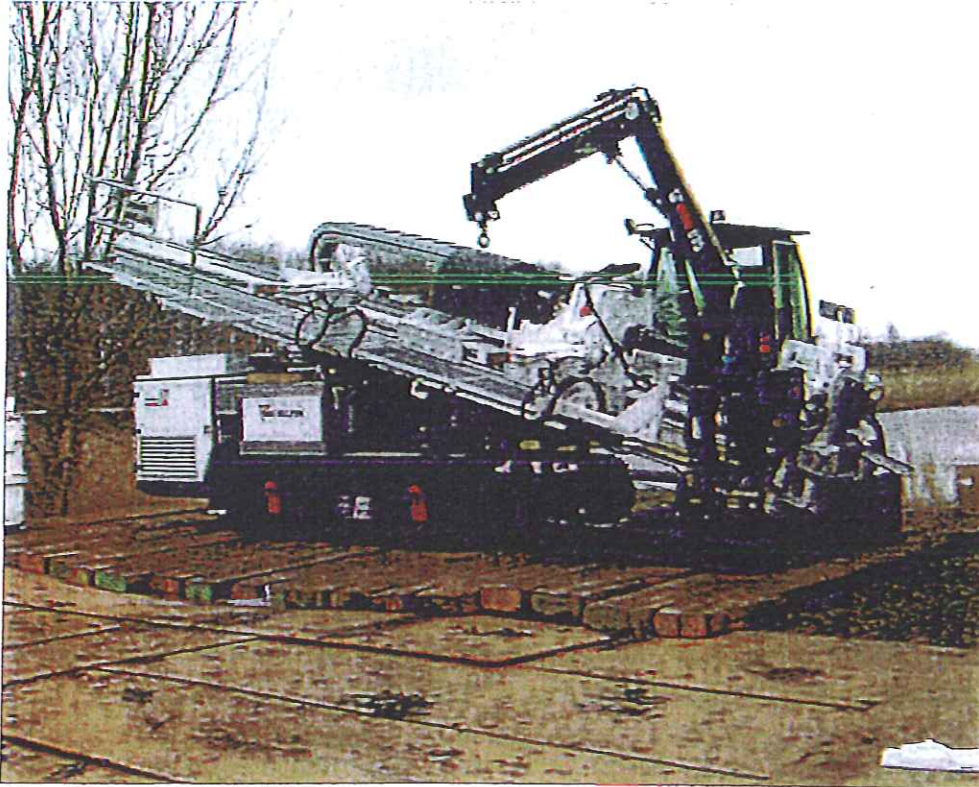
Afbeelding: 100 tons boor-rig Van Vulpen
