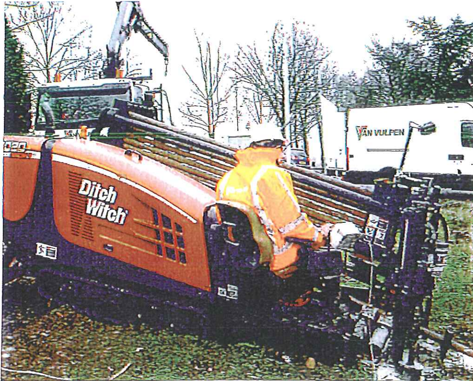
Afbeelding: 10 tons boor-rig Van Vulpem
