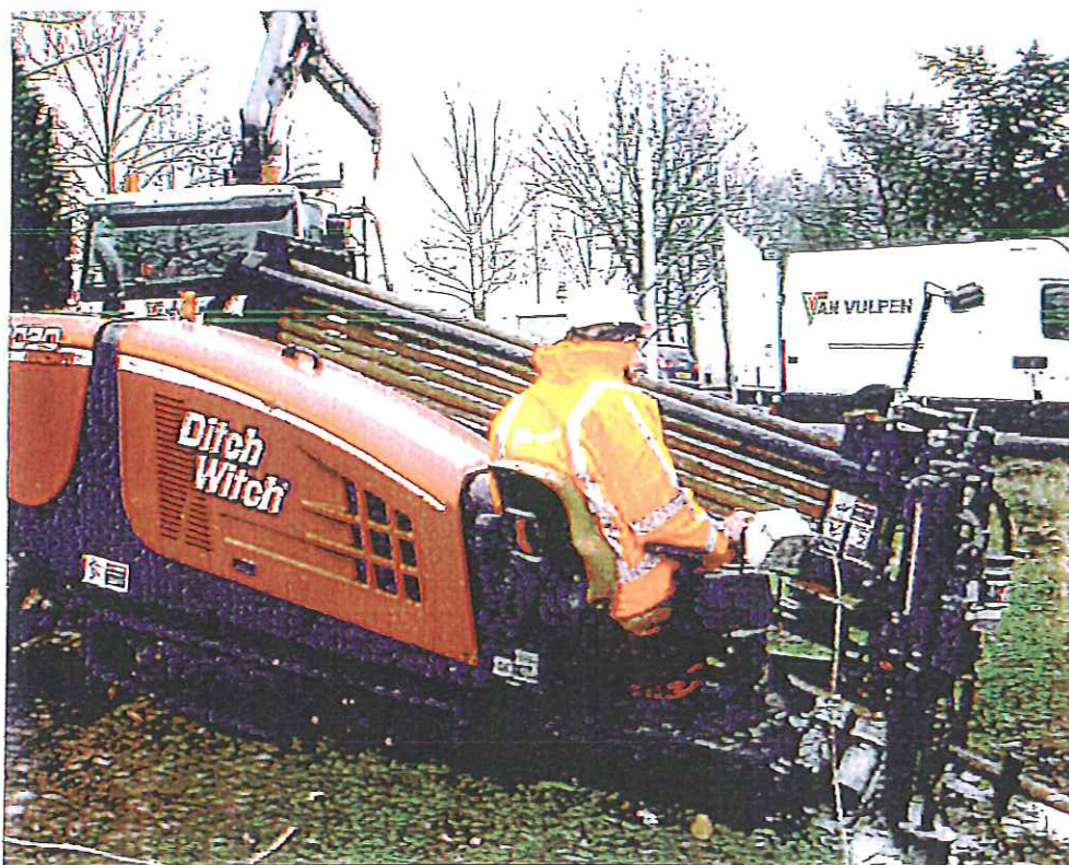
Afbeelding: 16 tons boor-rig Van Vulpen
