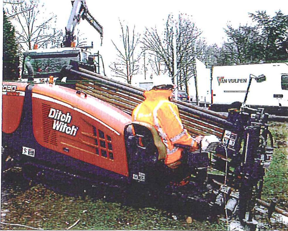
Afbeelding: 10 tons boor-rig Van Vulpen
