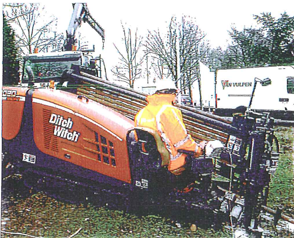
Afbeelding: 10 tons boor-rig Van Vulpen
