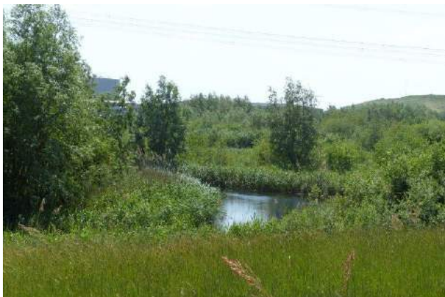
Foto 13 Effluentvijver van waterzuiveringsinstallatie
