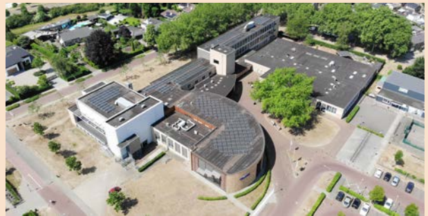
In een groot multifunctioneel gebouw als 't Mozaïek is energiemonitoring nog belangrijker (Credits: gemeente Wijchen)
