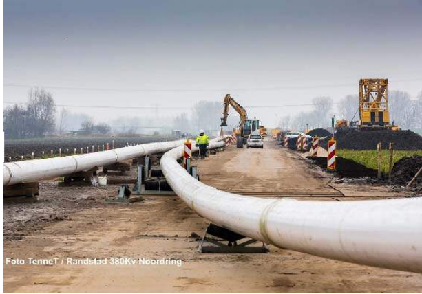
Figuur 6 Boring 2 circuits 380 kV
