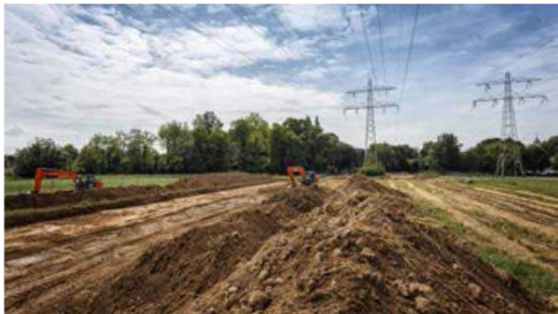
Figuur 8 en 9 Open ontgraving
