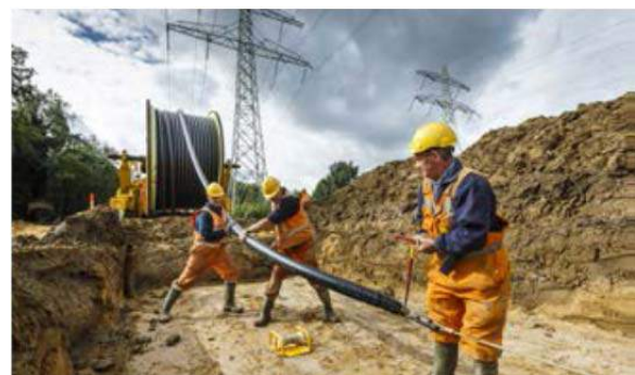
Figuur 7 Uitleglocatie boring van ca. 800 meter, de langste boring in de Noordring.
