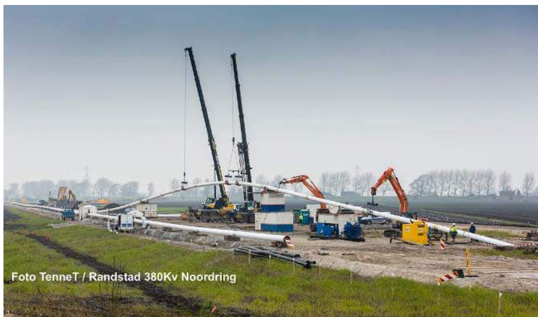
Figuur 5: Boring 2 circuits 380 kV
