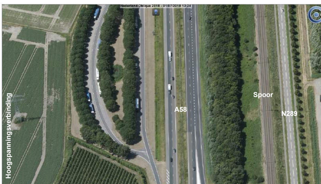
Figuur 19. Oblique luchtfoto van een deel van deelverbinding 1 ter hoogte van verzorgingsplaats 't Rak gezien vanaf het oosten, met daarop de huidige hoogspanningsverbinding, de A58, de spoorverbinding en de N289 (bron luchtfoto: Cyclomedia).
