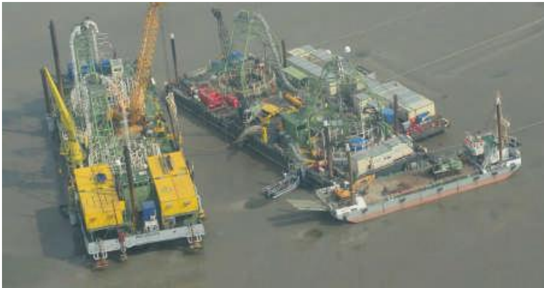
Figuur 1-11 Installatie in ondiepe zeegebieden (nearshore)
