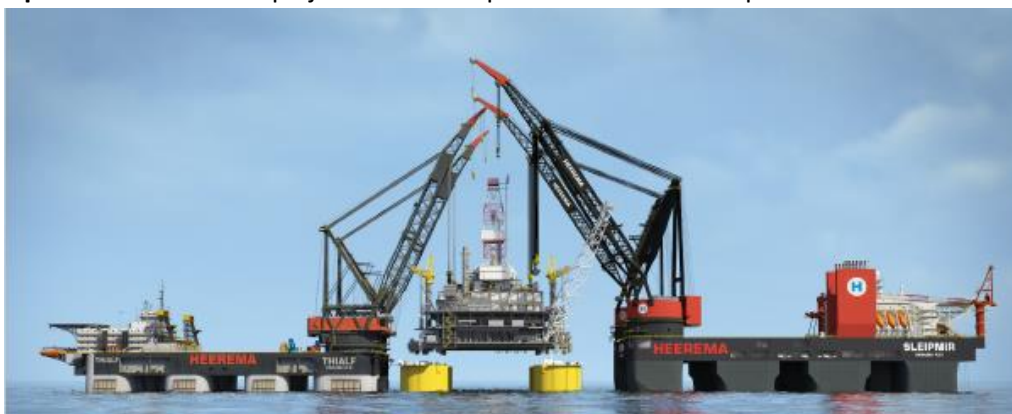
Figuur 1-5 Bovenbouw ophijsen met behulp van twee kraanschepen (hier: "Sleipnir" en "Thialf")
