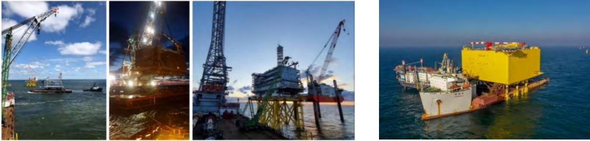
Figuur 12 Plaatsen van de topside door middel van een kraan (drie afbeeldingen links) of door deze over het jacket te varen (foto rechts)
