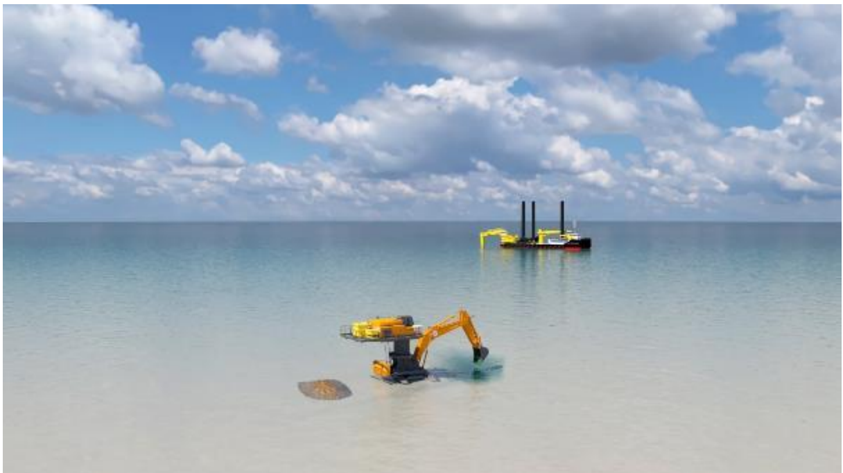
Figuur 4-6: Animatie van de 'Starfish' en 'Gian Lorenzo Bernini', bezig met het uitvlakken van de route
