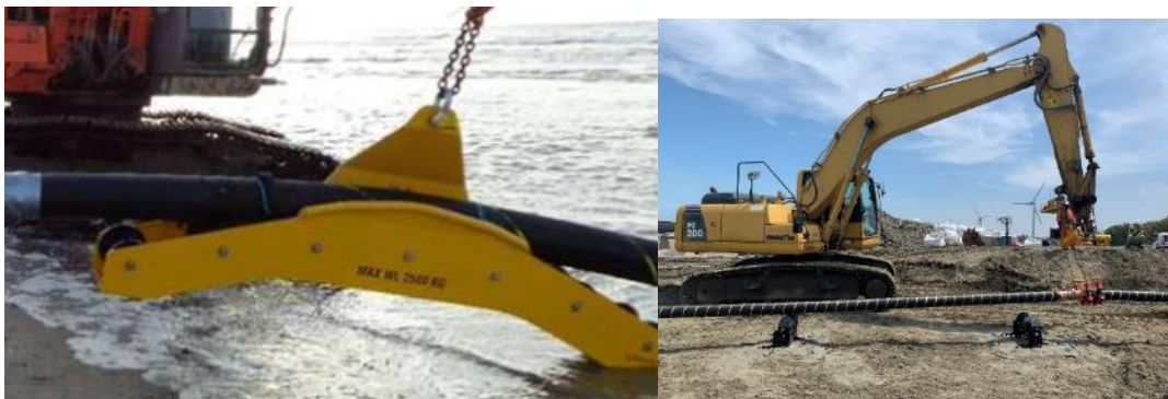
Figuur 3-8: Kabelgeleidingsboog (links) & kabel hijskader met rollen (rechts)
