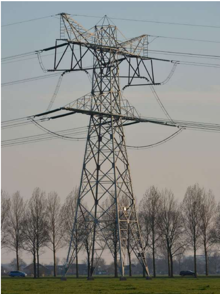
Figuur 2 Mast 37 met transpositie (bron: hoogspanningsnet.com)
