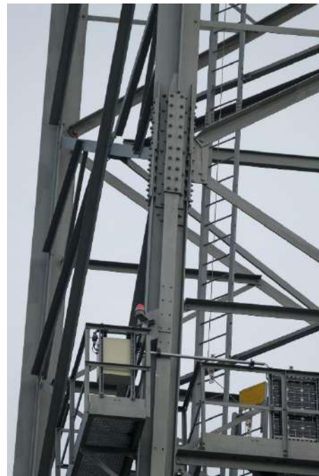
Overgang van INP naar XEA-kruisvormig profiel
