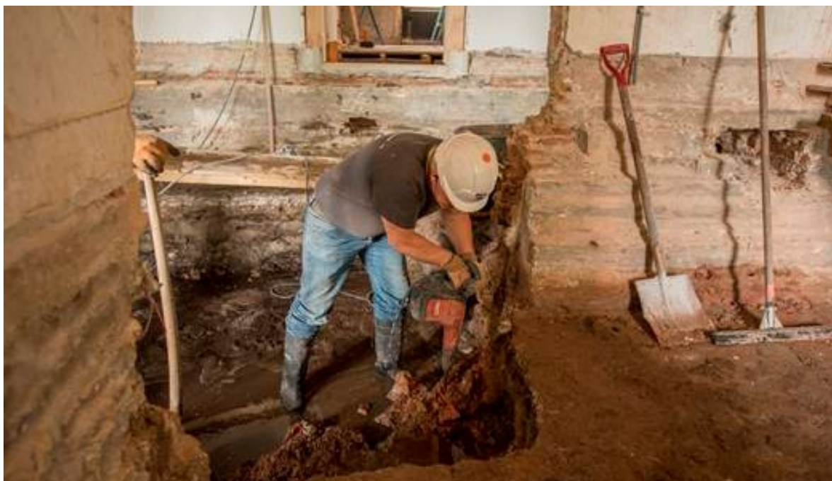
Figuur 4. Funderingsherstel in bestaande woning (Rijkvastgoedbedrijf René Verleg)
