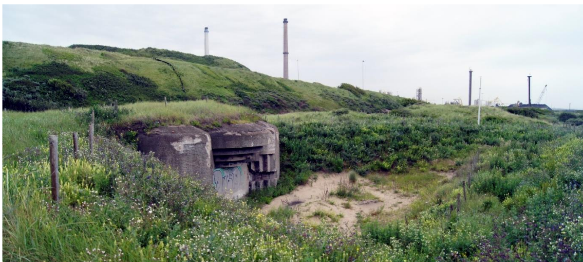
Figuur 4.20 Bunker in het jonge duinlandschap bij Wijk aan Zee, onderdeel van de voormalige Festung IJmuiden
