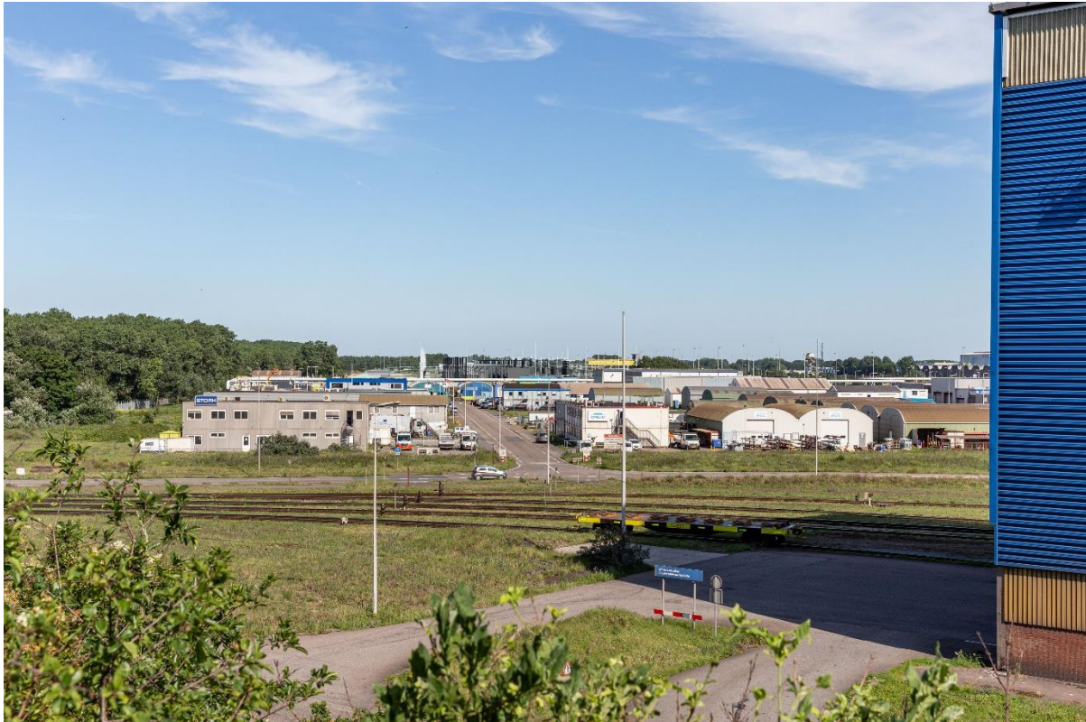
Figuur 4.26 Visualisatie vanuit standpunt 1, met het transformatorstation Zeestraat
