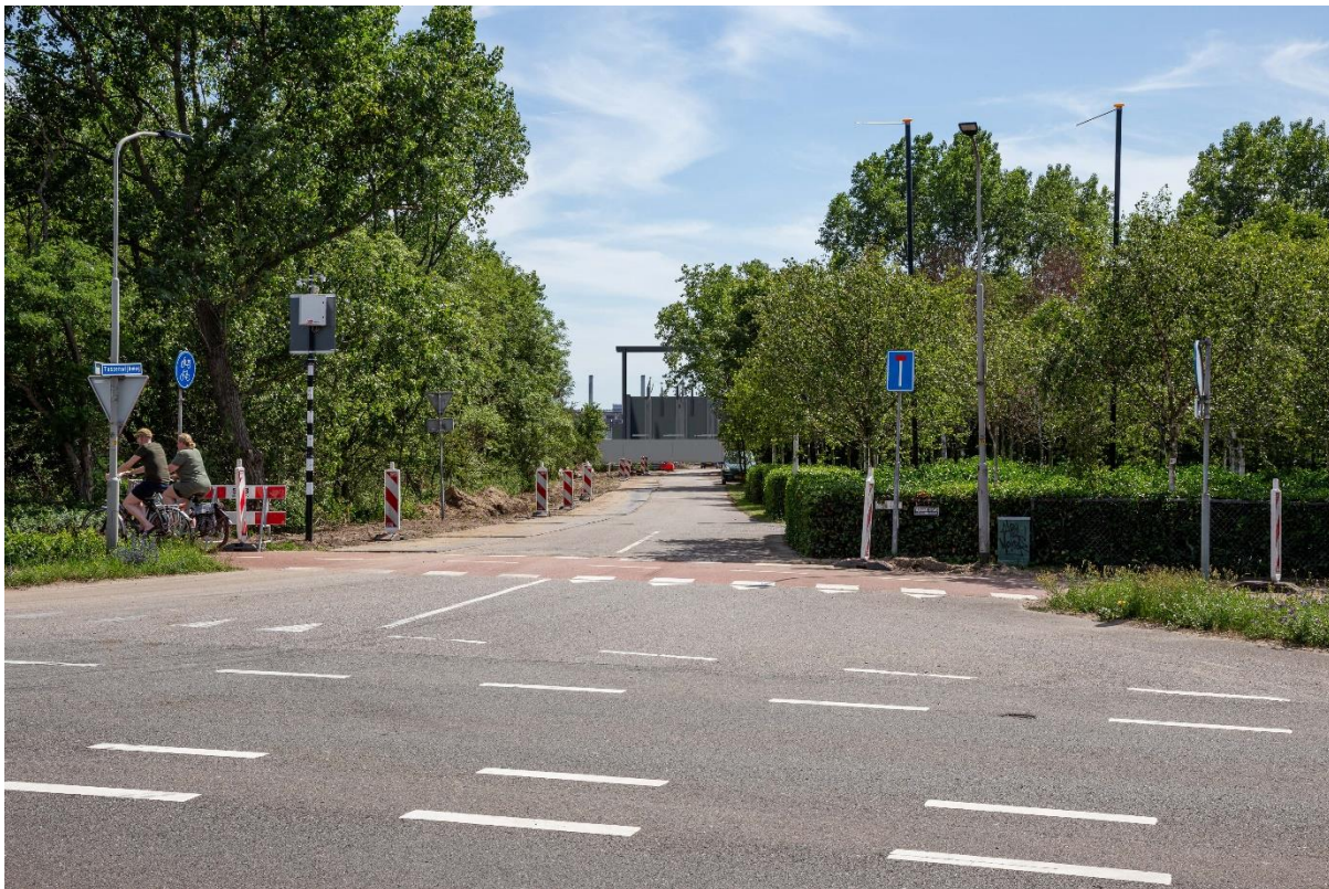
Figuur 4.27 Visualisatie vanuit standpunt 3, met het transformatorstation Zeestraat
