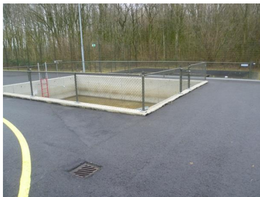
foto 2: Vuilwaterput / calamiteitenbak verharding
