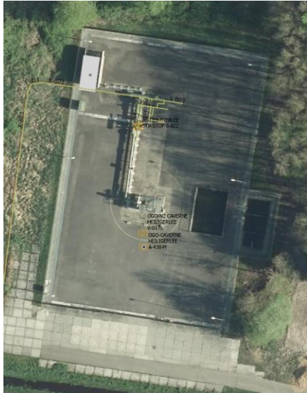
Bovenaanzicht huidige installatie
