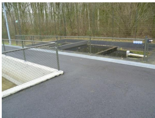
foto 2: Vuilwaterput / afscheider ringgoot
