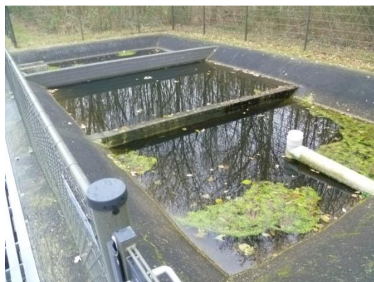
foto 1: Vuilwaterput / afscheider ringgoot
