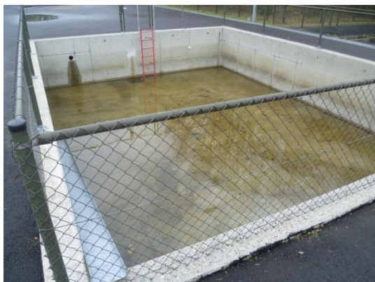
foto 1: Vuilwaterput / calamiteitenbak verharding
