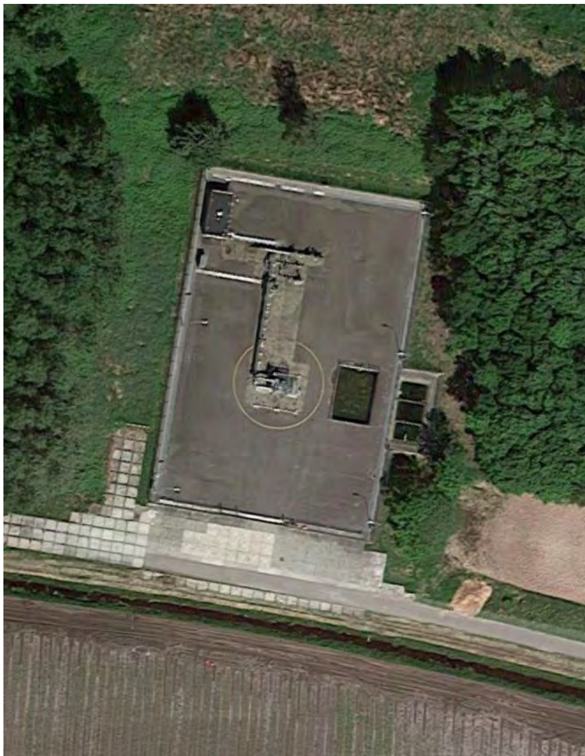
Figuur 20 foto opslaglocatie
