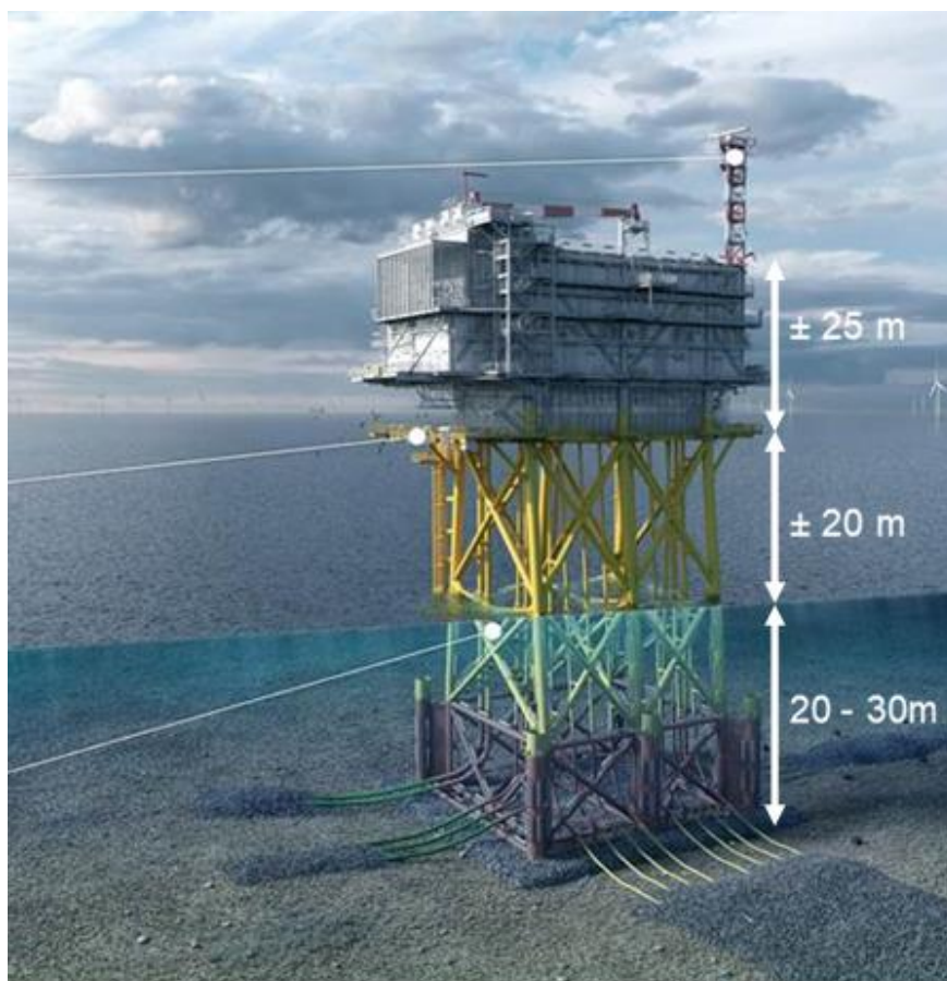
Figuur 3.1 Standaard 700 MW AC offshore platform. De gele constructie is de jacket fundering.
