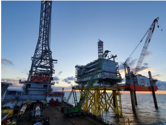
Figuur 3.3 Impressie plaatsing topside op jacket.
