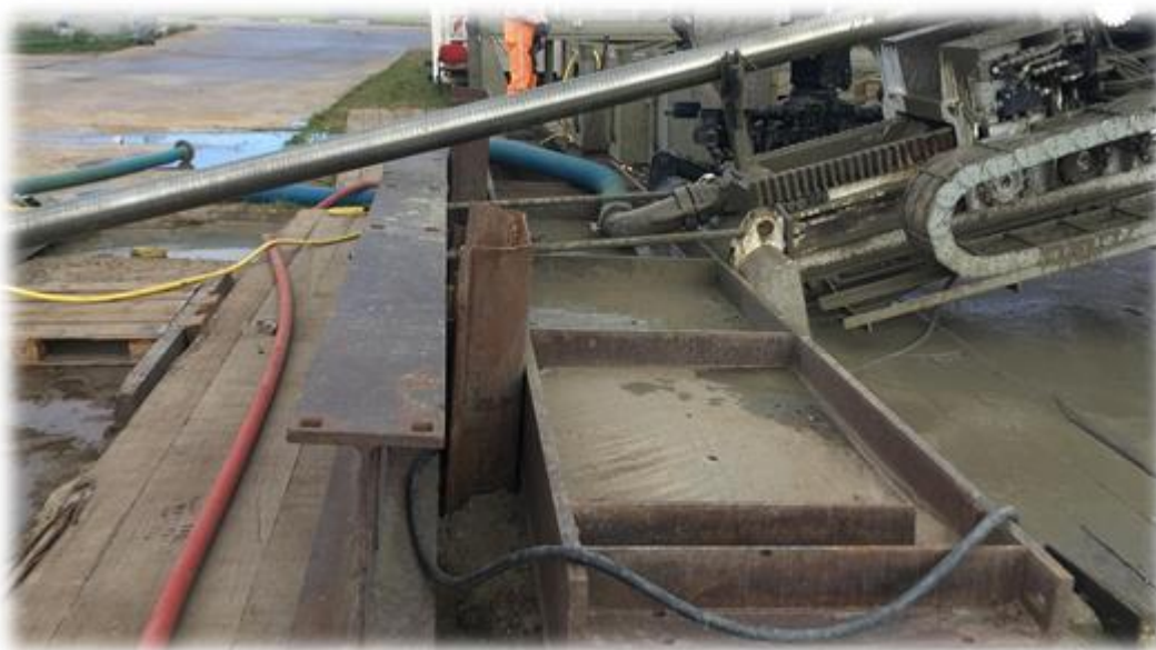
Afbeelding 15 - Voorbeeld opbouw verankeringswand
