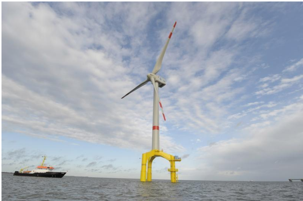
Figuur 2.7 Voorbeeld van een tripile fundatie 3 .
