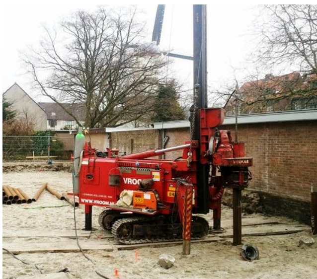
Figuur 20 Voorbeeld van heistelling voor schroefinjectiepaal
