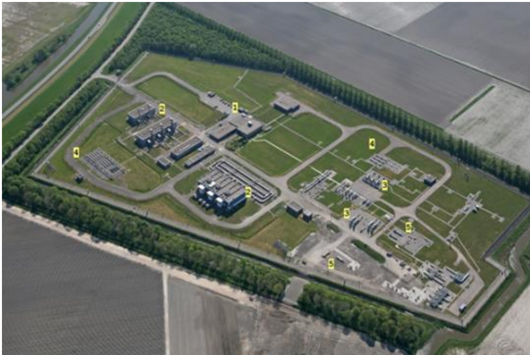
Figuur 2.6 Luchtfoto bestaand compressorstation
