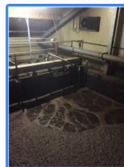
Zeefbandpers + 7 meter biologietank voor omzetten NH 3 naar N 2
