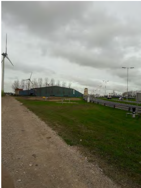
Fotonummer: 7 Omschrijving: Het tracé nabij het Hartelkanaal. Kijkrichting noordwest.
