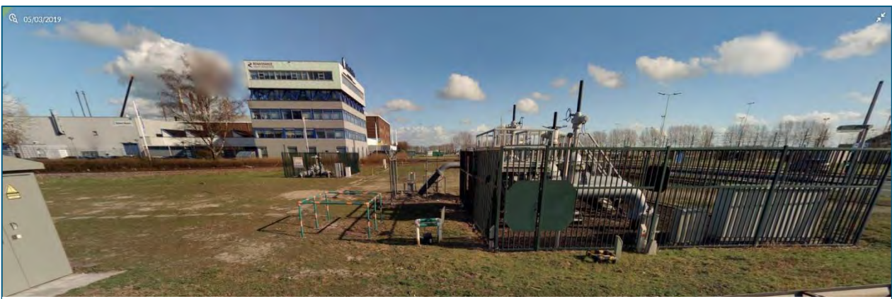
Figuur 4-3 Typisch beeld van de leidingstrook (hier de Welplaatweg) met pompinstallaties en kale stukken grond (Cyclomedia).
