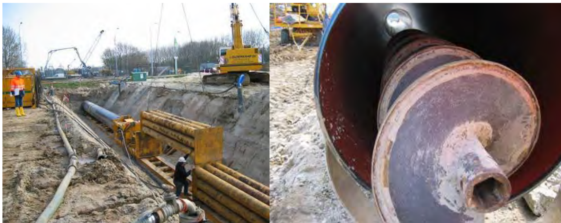
Figuur 3.35. Opstelling open front techniek
