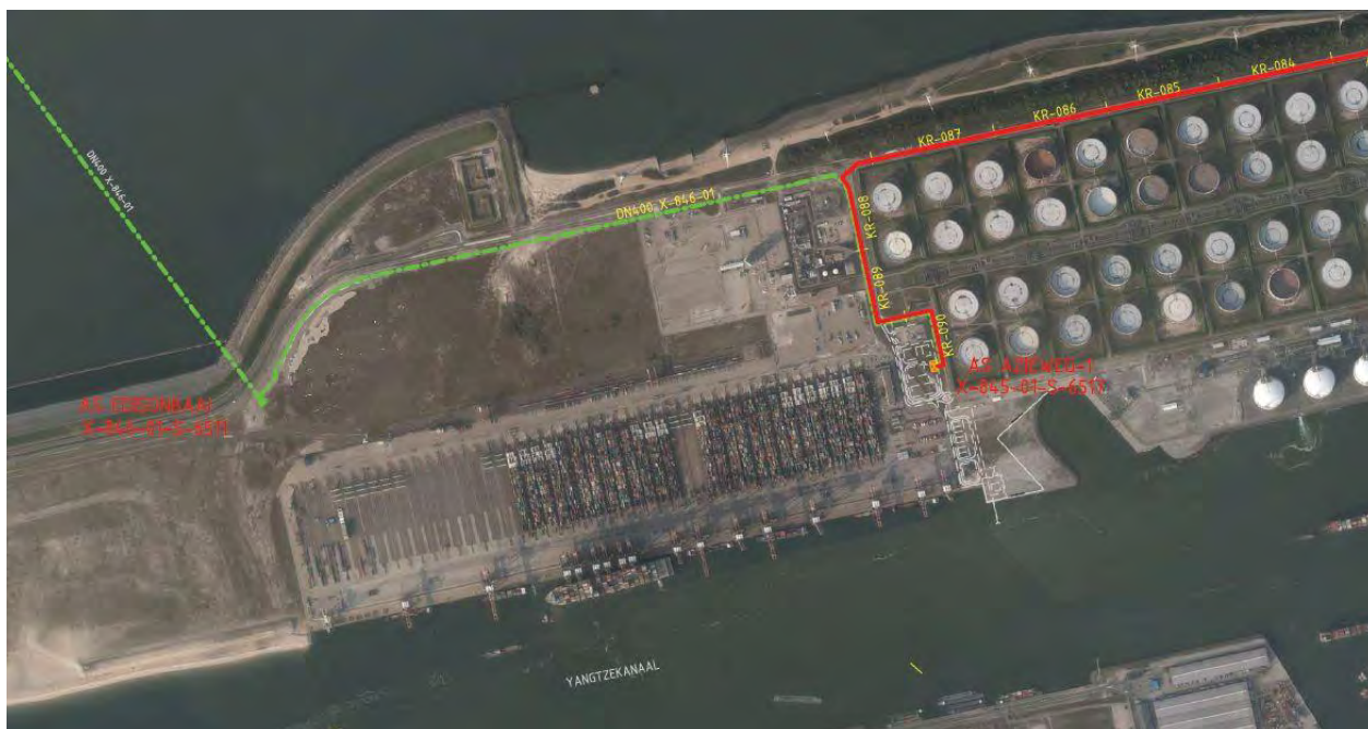
Figuur 3.16. Compressorstation Aziëweg en kruising zeevering
