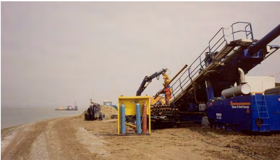
Figuur 3.31. Foto van een boorstelling voor HDD-boring
