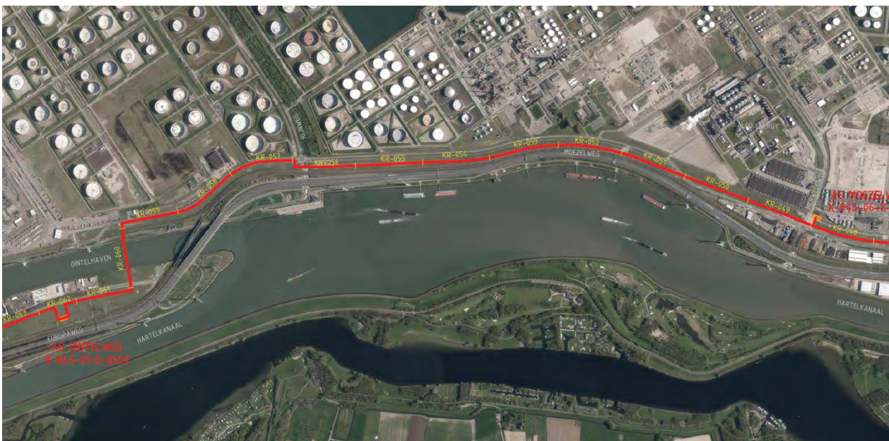
Figuur 3.13. Vervolg langs Dintelhavenbrug
