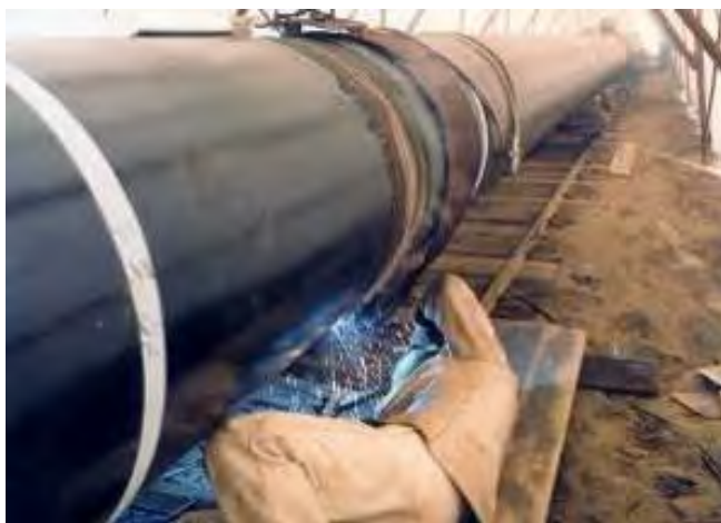
Figuur 3.24 Lassen van de leiding
