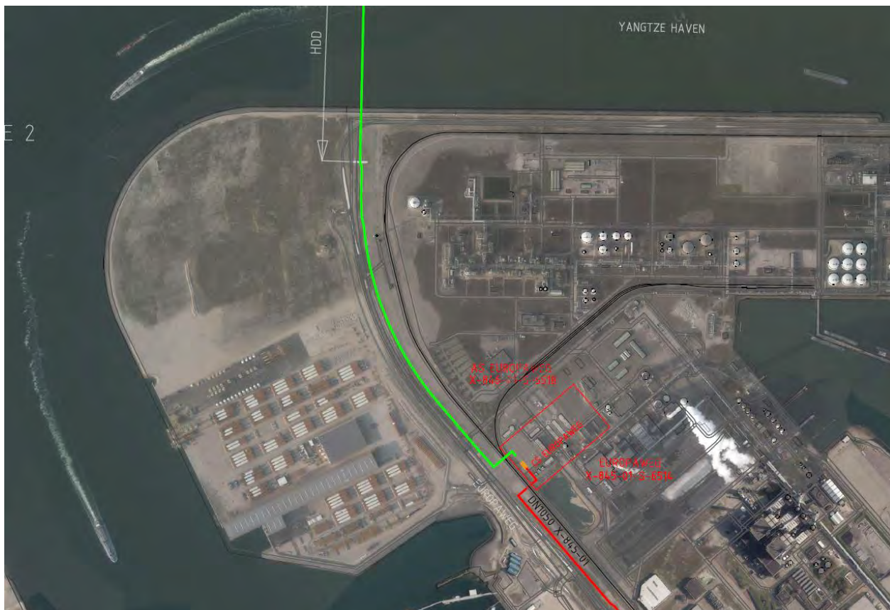
Figuur 3.20. Compressorstation locatie Europaweg
