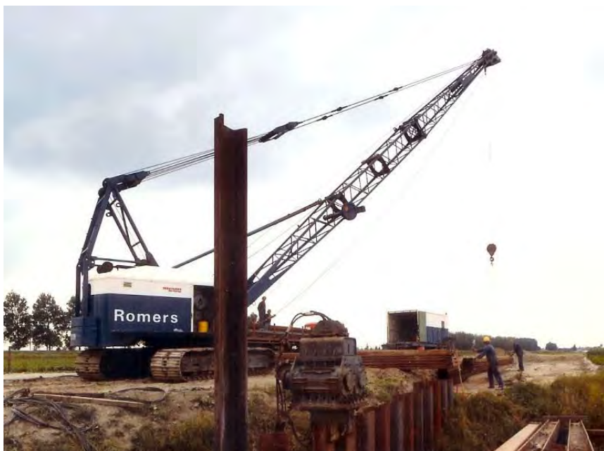
Figuur 3.28. Slaan van damwand
