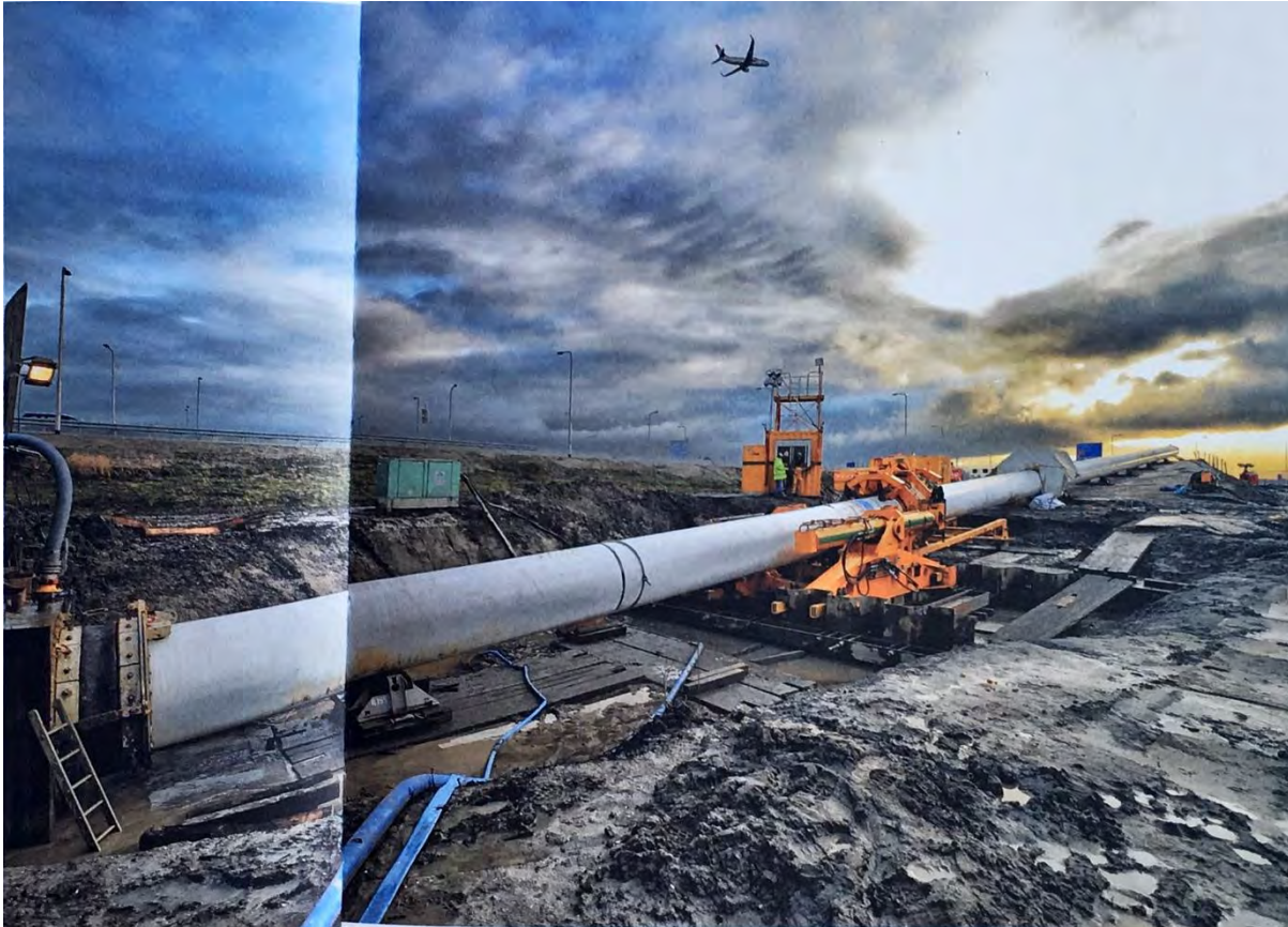
Figuur 3.34. Opstelling direct pipe boring
