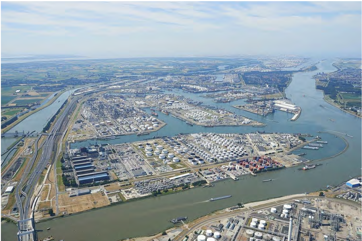
Figuur 3.2. Luchtfoto Botlekgebied (bron: Havenbedrijf Rotterdam, 2019)
