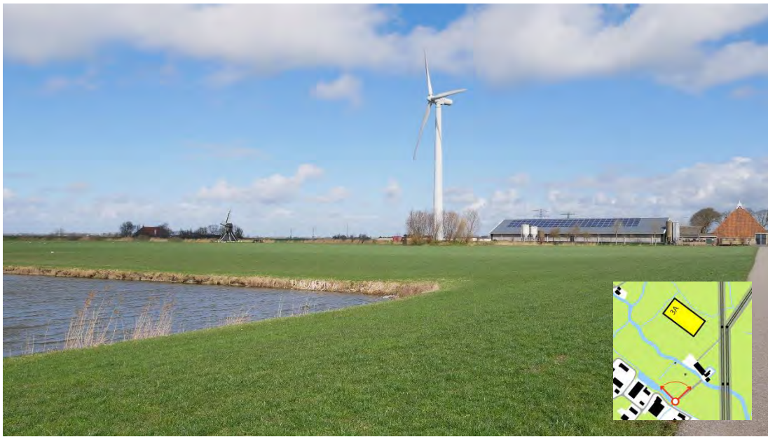
Afbeelding 2.9 Visualisatie representatieve locatie 3A, gezien vanaf het zuiden (zie rode pijlen voor het precieze standpunt). Boven: huidige situatie, onder: nieuwe situatie
