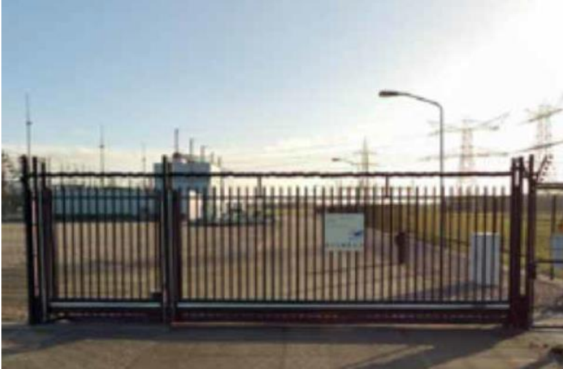
Figuur 11 Voorbeeld toegangspoort TenneT station
