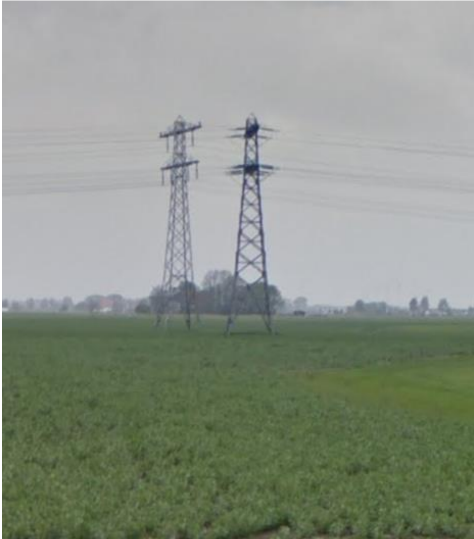
Figuur 14 Mast 45 (links) en mast 52 (rechts) gezien vanaf de N359 (bron: google maps)
