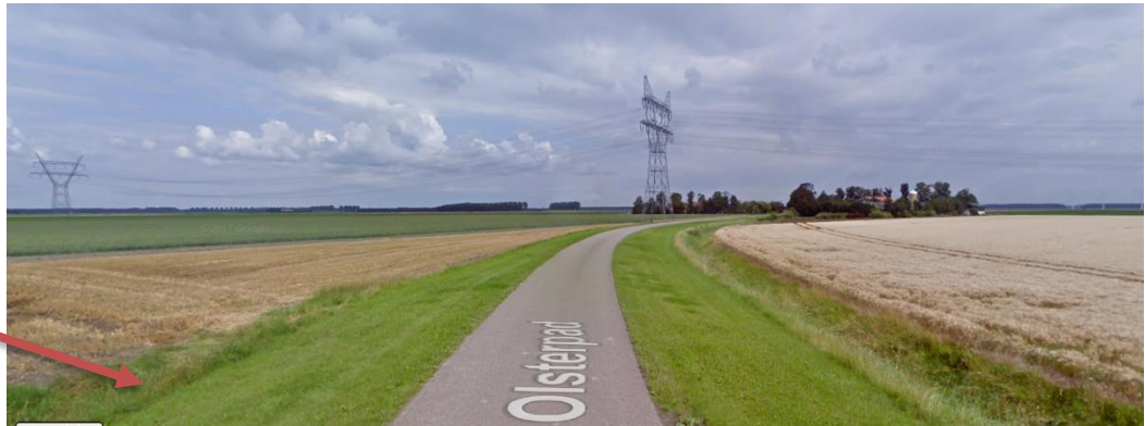
Figuur 2.5 Locatie in-uitrit onderstation (kijkrichting noorden)
