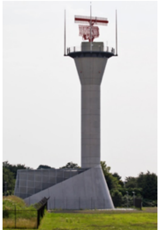
TAR West radar op Schiphol. Bron: LVNL
