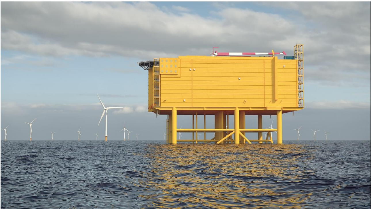
Figuur 2-1 Artist 's impressions van een 2 GW platform voor IJmuiden Ver (met een stalen draagconstructie).
