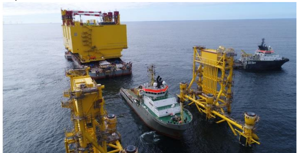
Figuur 1-3 Bovenbouw invaren en neerlaten door het transportschip te laten inzinken ("zware lading schip")
