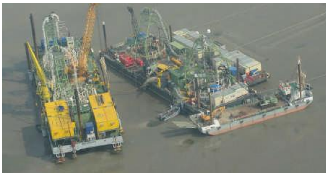
Figuur 1-9 Installatie in ondiepe zeegebieden (nearshore)
