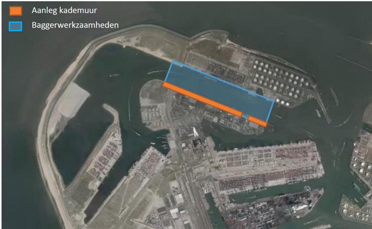
Figuur 1–30 Projectgebied verbreding Yangtzekanaal (Bron: Havenbedrijf Rotterdam)
