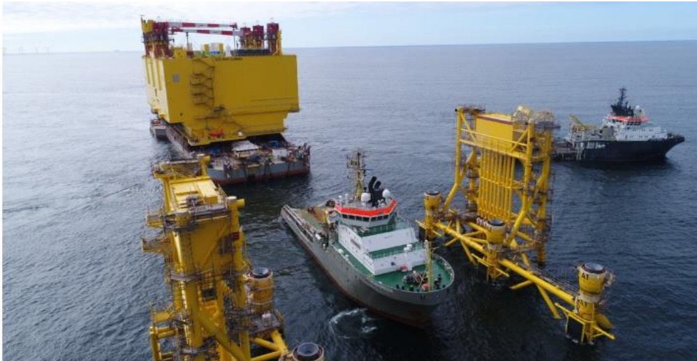
Figuur 1-3 Bovenbouw invaren en neerlaten door het transportschip te laten inzinken
