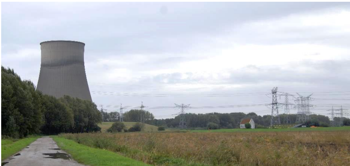
Figuur 6-17 Geertruidenberg - Koeltoren Amercentrale en Huis ten Halve
