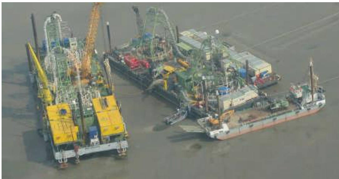
Figuur 1-9 Installatie in ondiepe zeegebieden (nearshore)
