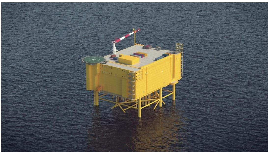
Figuur 6-1 Artist's impression van een 2 GW platform voor IJmuiden Ver (met een stalen draagconstructie)
