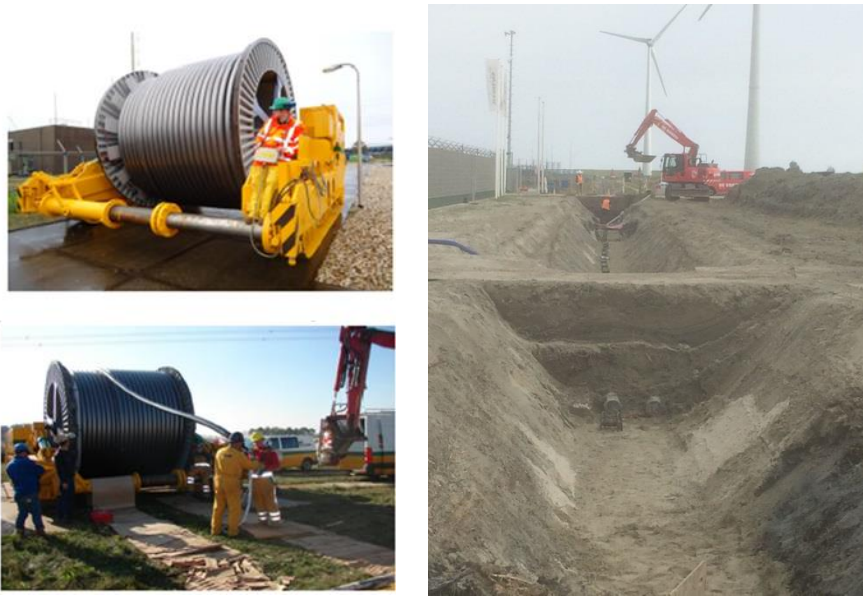
Figuur 5-5 Typische land of onshore kabelinstallatie
