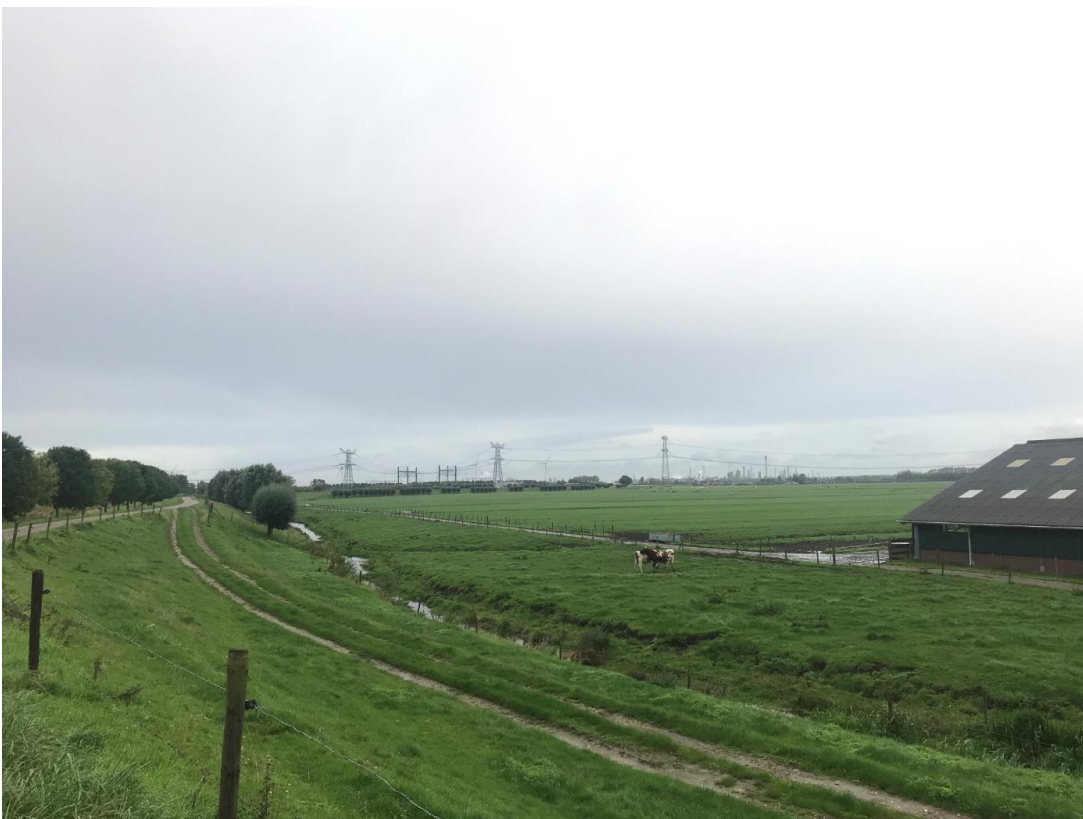
Figuur 6. Zicht op het bestaande transformatorstation vanaf de Biertsedijk (foto Koos Mol op 09-10-2019).
