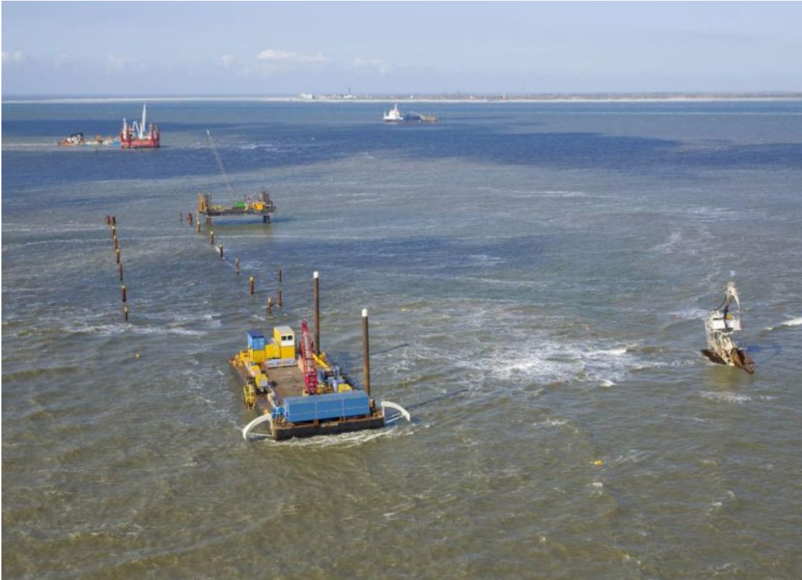
Afbeelding 2.10 Platformen en schepen bij een HDD-boring op zee
