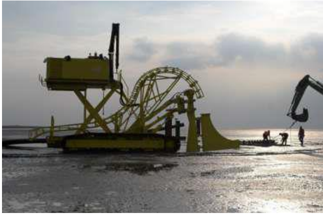
Afbeelding 2.11 Voorbeeld van een wad-trencher met een trilzwaard op rupsbanden
