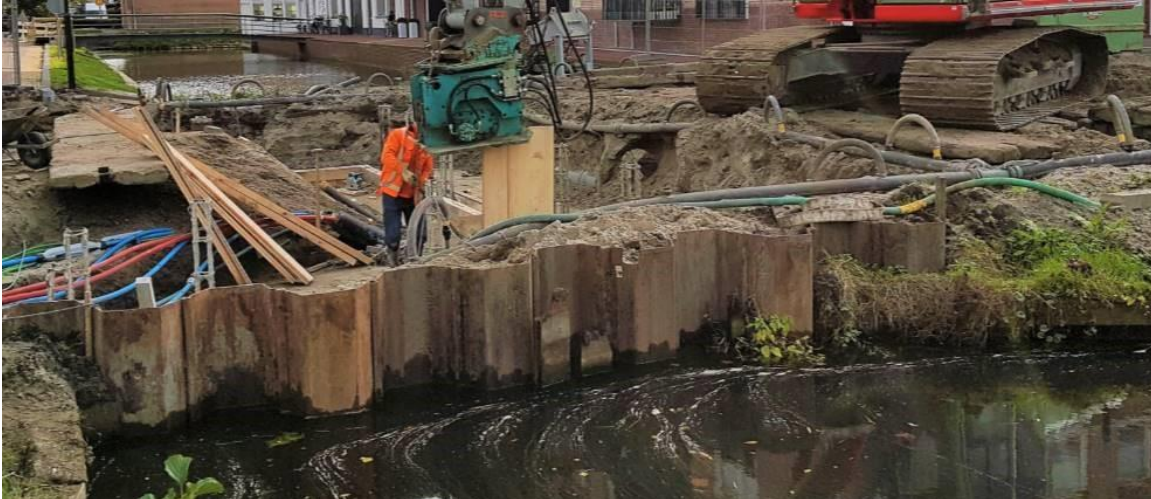
Afbeelding 2.16 Voorbeeld van plaatsing van een zinker bij een waterweg
