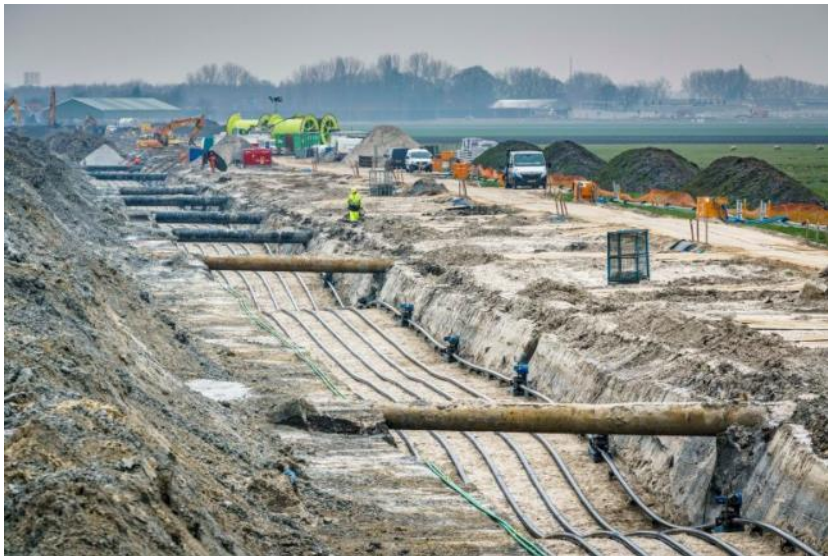
Afbeelding 2.14 Voorbeeld van een sleuf waar de kabels worden neergelegd
