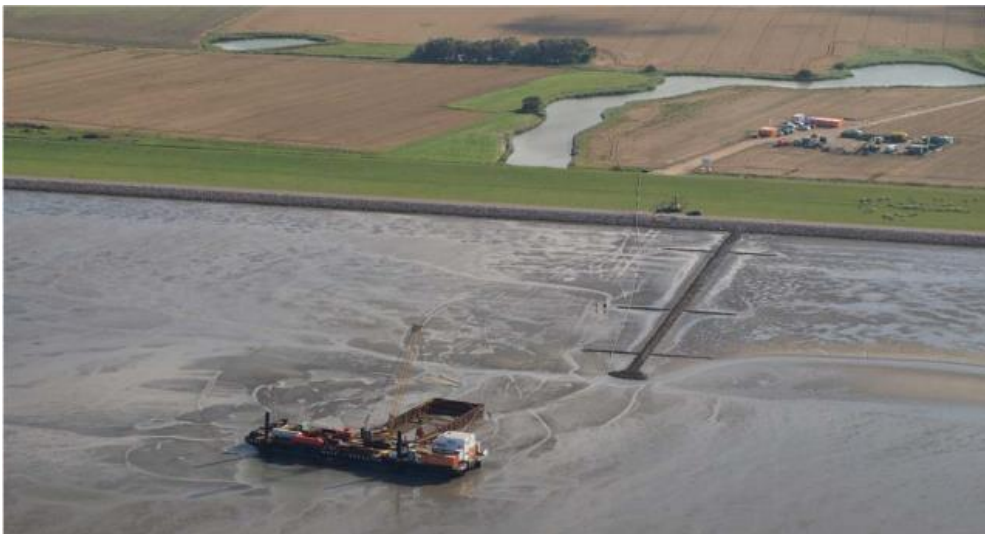
Afbeelding 2.7 Voorbeeld van een aanlanding met een kofferdam, nabij schip
