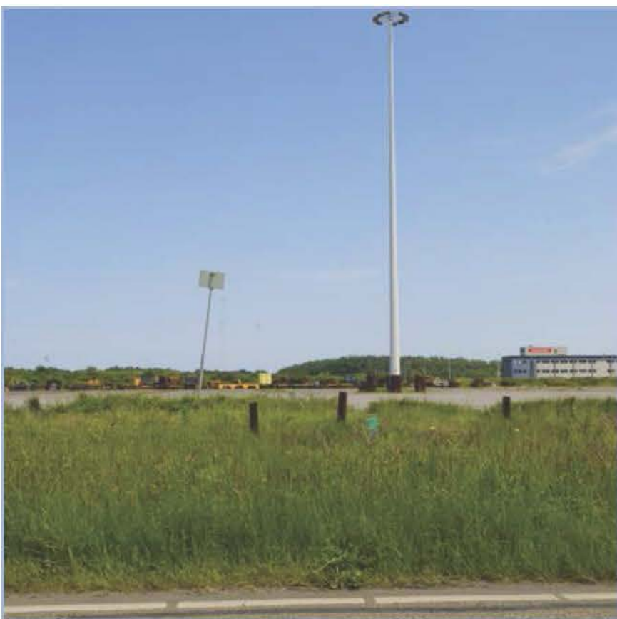
Zonder aarden wal langs de weg is de verharding van het terrein naast de weg goed te zien en wordt de beleving van het duinlandschap versnipperd.
