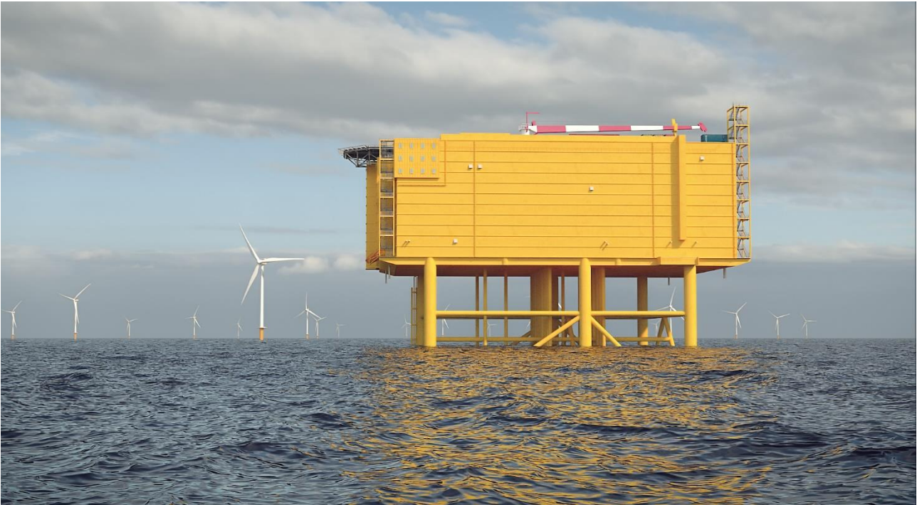
Figuur 2-1 Artist's impression van een 2 GW platform voor IJmuiden Ver (met een stalen draagconstructie).
