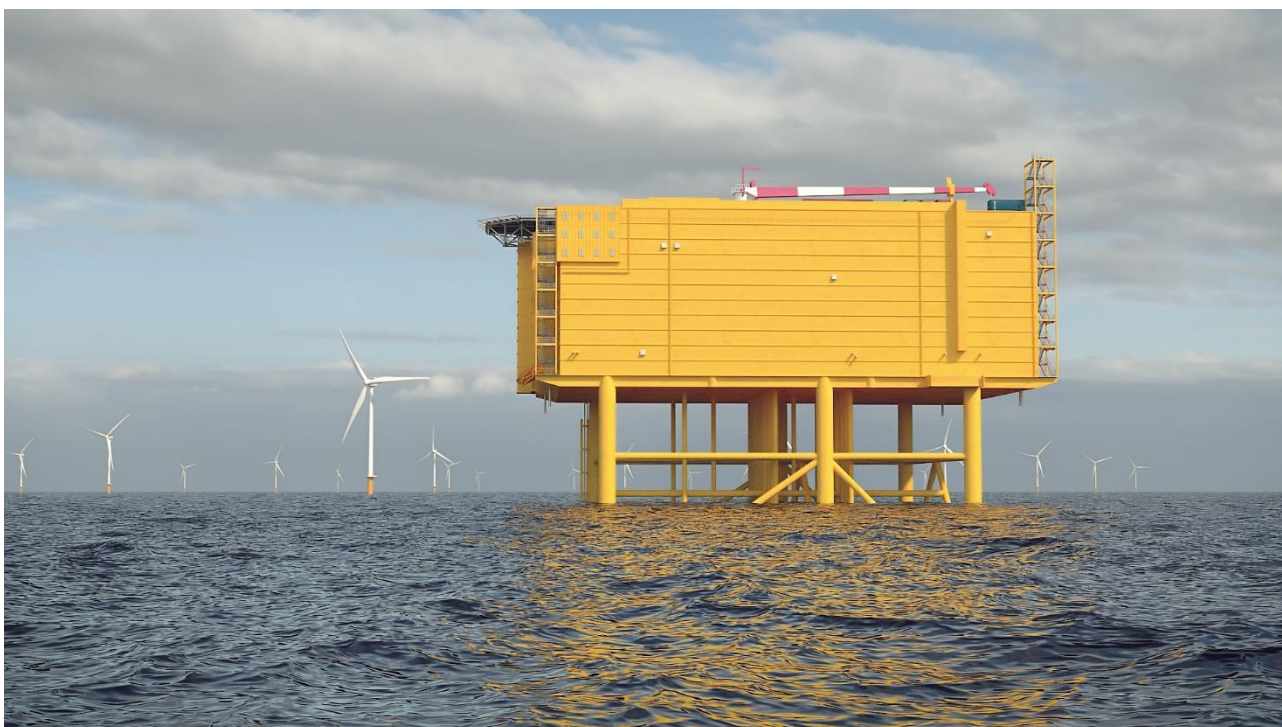
Figuur 1-3 Artist's impression van een 2 GW platform voor IJmuiden Ver (met een stalen draagconstructie).
