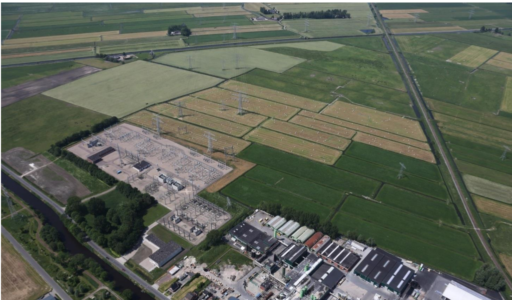
Foto 4: Bedrijventerrein Westpoort met transformatorstation Vierverlaten
