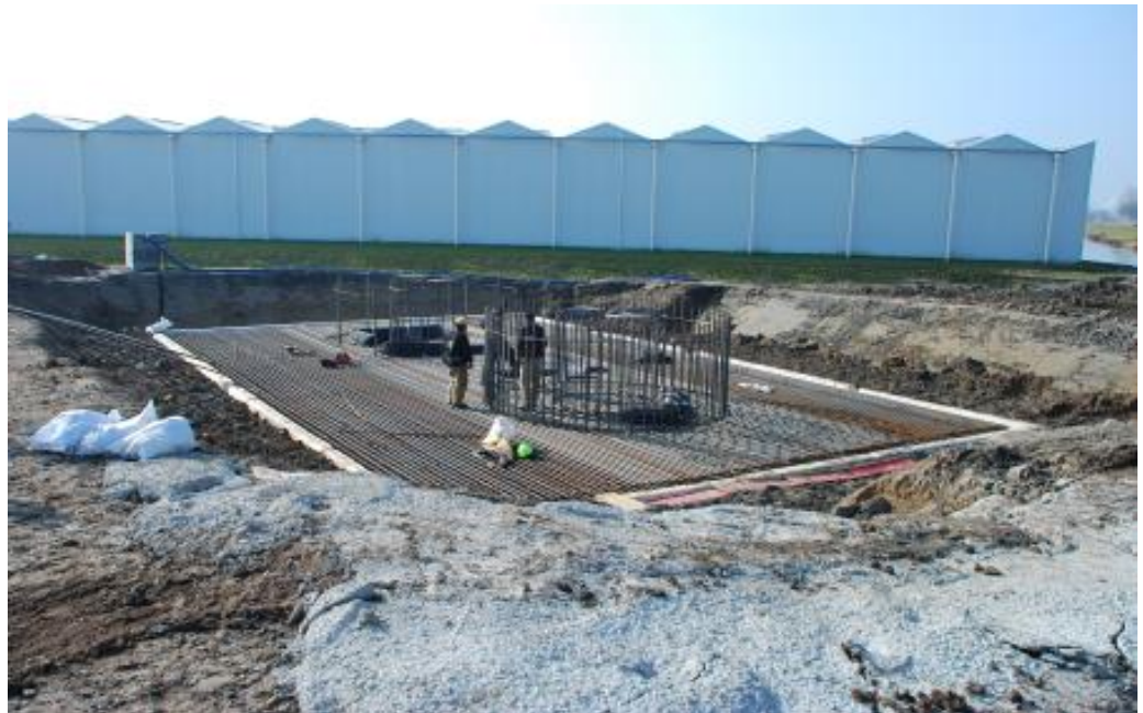
Foto 16: Aanbrengen bewapening
