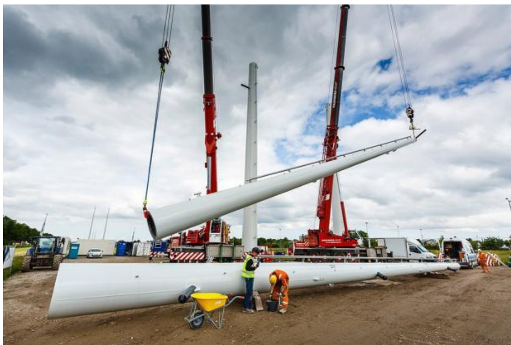
Foto 6: plaatsing van een Wintrackmast
