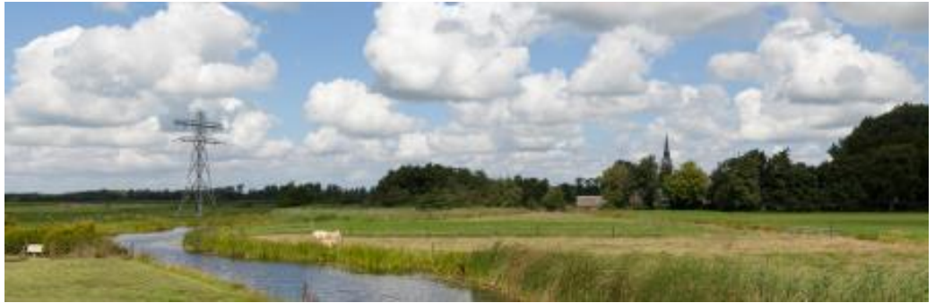
Foto 11: Watergang met hoogspanningsverbinding
