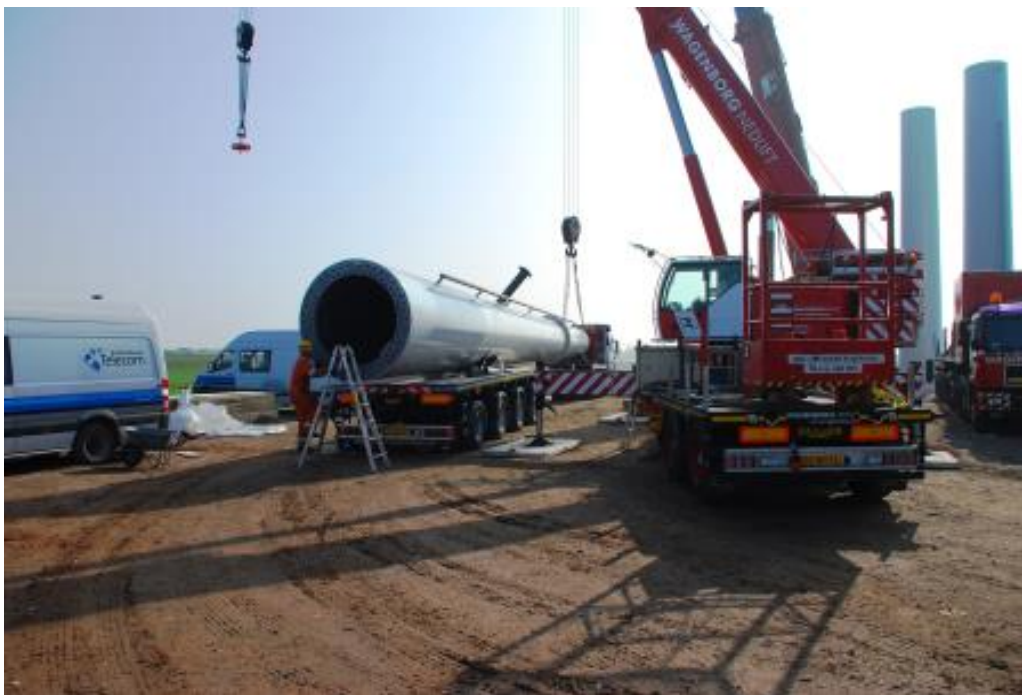
Foto 17: Assemblage mast
