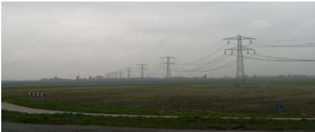
Foto 15: Bestaande hoogspanningsverbinding bij nat weer
