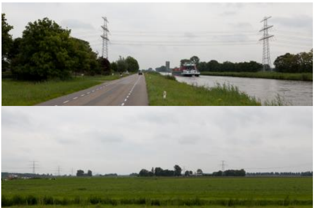
Foto 12: Aduarderdiep met bestaande 110 en 220 kV-verbindingen
