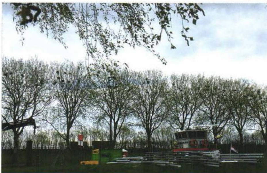
Enkele bomen ter hoogte van Duurkenakker. Voorjaar 2019 ten tijde van bouw remmingswerken. De roekenkolonie heeft zich verplaatst naar Duurkenakker.
