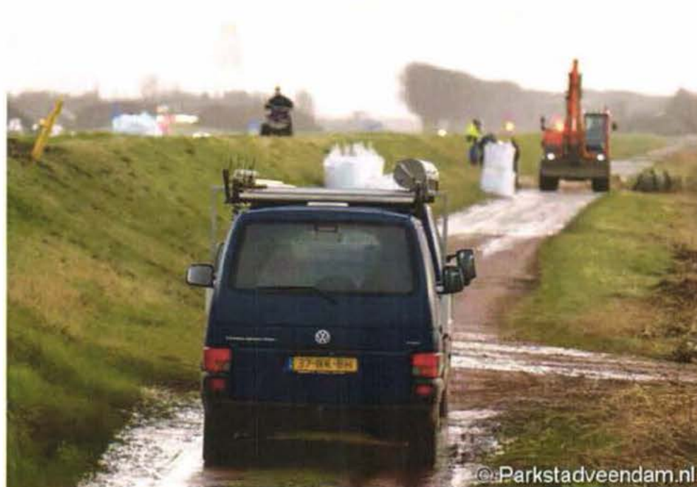
Foto van dijk A.G. Wildervanckkanaal die werd verzaaid met zandzakken in 2012
