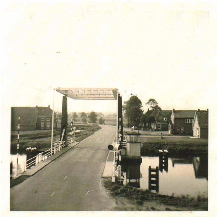
Deze nog steeds bestaande Meedenerbrug op Duurkenakker uit de jaren 50 (familiealbum, jaren 60). Aan deze brug zijn in de 2003 fietsstroken bevestigd. Het is de toegangsweg vanaf Rijksweg N33 naar Railport Groningen, Veendam-Noord, de nieuwe naar de stikstoffabriek en de doorgaande weg van Meeden naar Muntendam.
