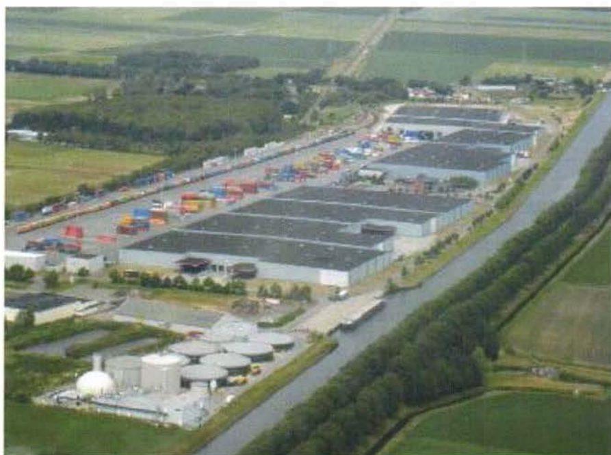
Op voorgrond biomassa vergistingsinstallatie, noordoostkant Duurkenakker.
