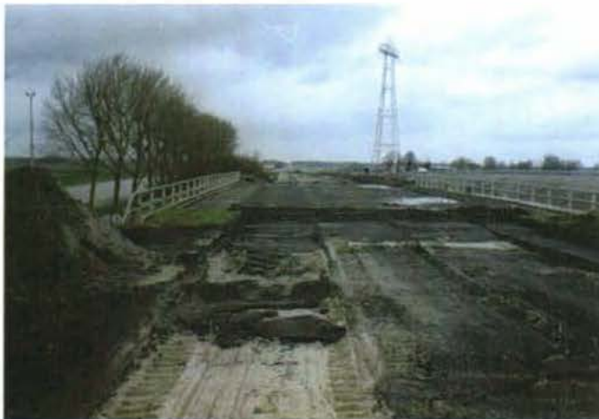
Oude viaduct Duurkenakker wordt afgebroken.
